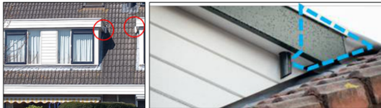
Afbeelding 34: Links: bekende huismusnesten in ruimte in dakgootbekisting bij dakkapel (locatie: ergens in Ridderkerk). Rechts: deel van de dakgootbekisting dat beschikbaar zou moeten zijn voor de huismus. Hierop zijn de genoemde afmetingen van toepassing.
