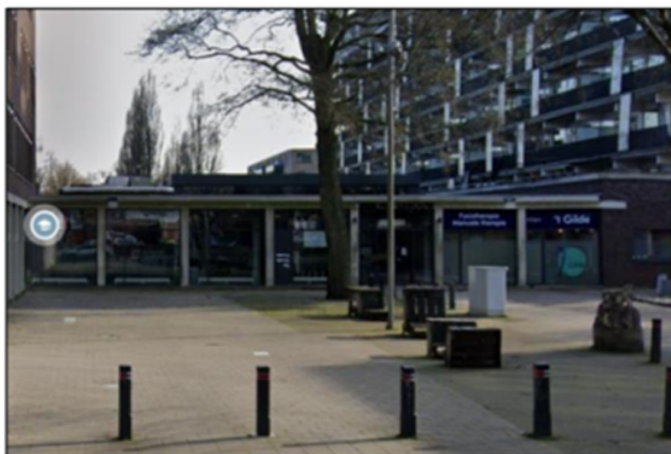
Afbeelding 14: Deel van "Het gebouw", dat op Afbeelding 6 is aangegeven met de letter "H". De gevel bestaat grotendeel uit glas, en verder uit een betonnen constructie. Er zijn geen openingen aanwezig in het beton, die toegang verschaffen tot een geschikte ruimte. De laagbouw is voorzien van een met bitumen bekleed plat dak. Ook hier ontbreekt mogelijke toegang tot geschikte ruimten. Foto: Google Maps.
