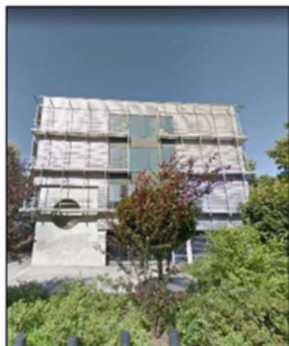
Afbeelding 13: Bebouwing die op Afbeelding 6 staat aangegeven met de letter "G". Het gebouw lijkt opgetrokken uit beton (onderste verdieping) en is afgewerkt met stalen gevelplaten. Er zijn geen openingen aanwezig die toegang bieden tot geschikte ruimten. Foto: Google Maps.
