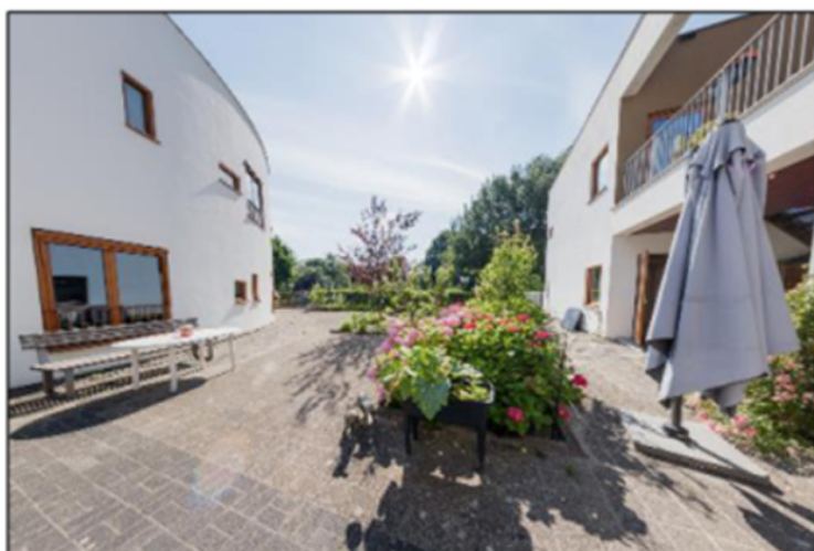
Afbeelding 10: Het Gasthuis te Gorinchem, dat met een 'D' staat weergegeven in Afbeelding 6. De bebouwing is aan de buitenzijde volledig afgewerkt met een soort stukwerk, waardoor er geen toegang is tot ruimte in muren. Gevelbetimmering ontbreekt. De stalen dakranden bieden geen toegang tot geschikte ruimten. De bebouwing is vrij nieuw en goed onderhouden, waardoor ook geen gaten zijn ontstaan bij kozijnen e.d.. Foto: Rivas Zorggroep
