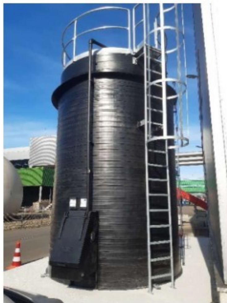
Voorbeeld opslagtank met vulkast (ladder en reling hoort niet bij de levering)
