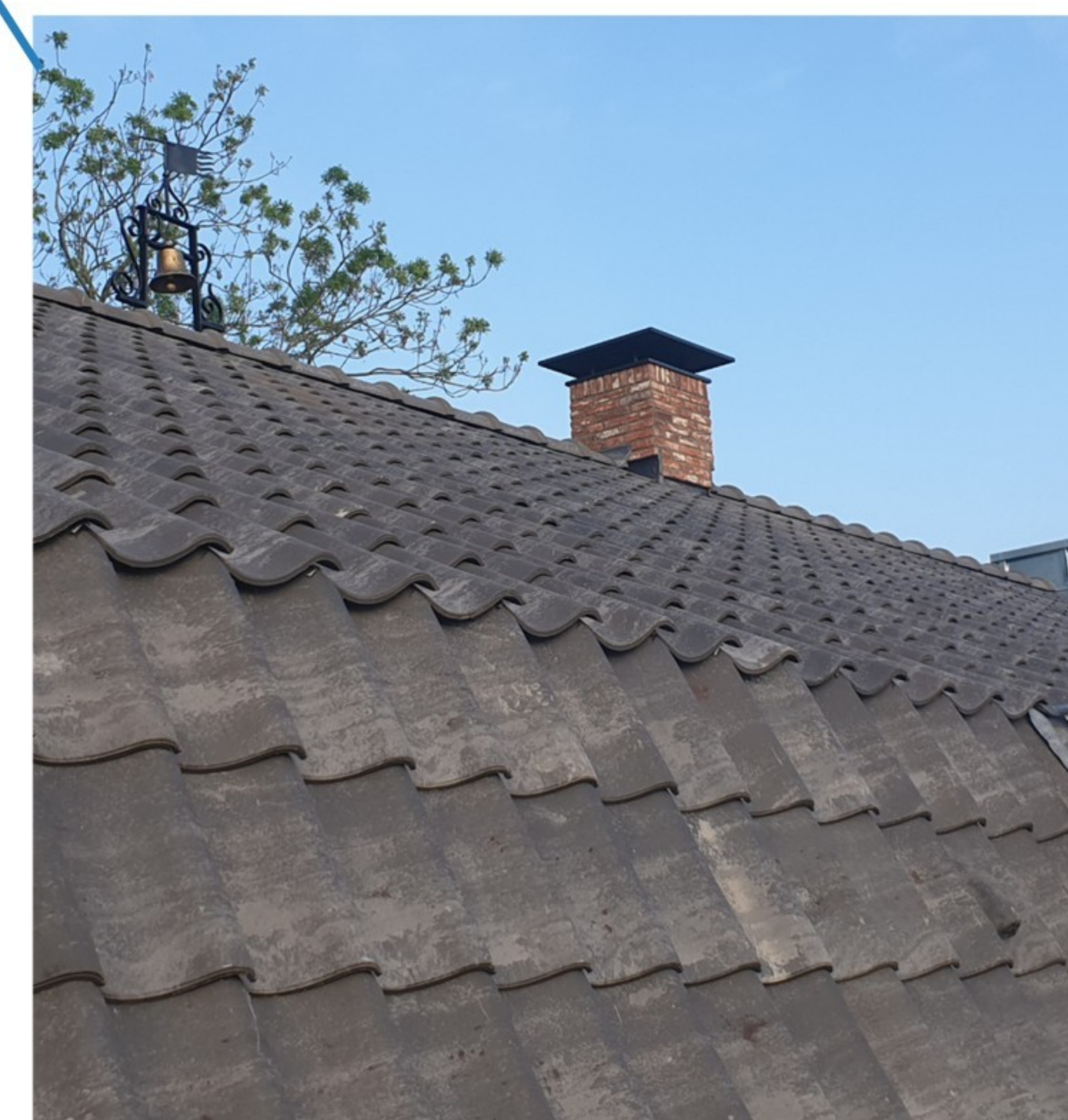
Dakpannen als bazenwoning (zie fragment)
