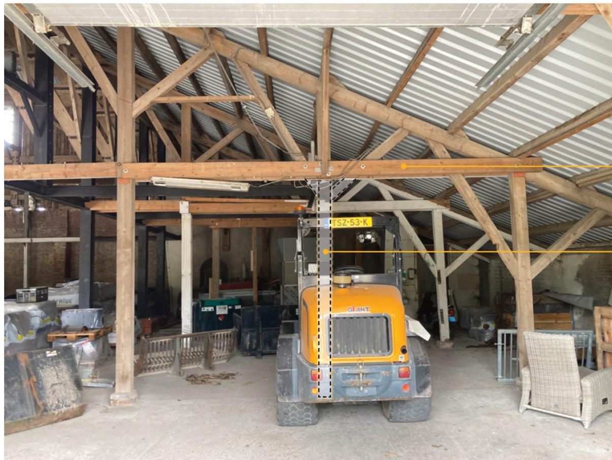
Constructie turfloods (rechter travee)
