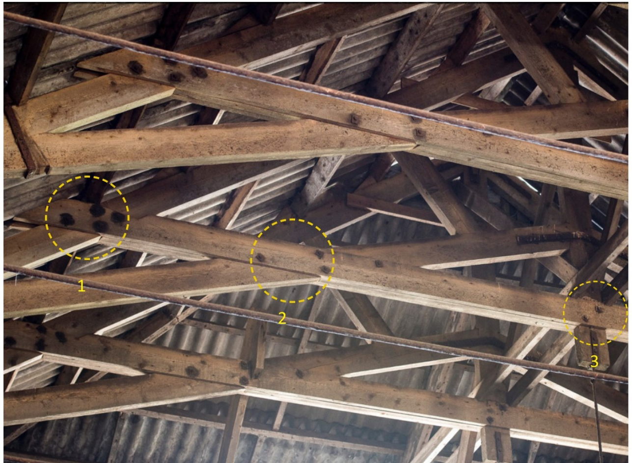
Trekbal overgekeept over spantbeen (verbinding 1) schoor (verbinding2) en makelaar (verbinding 3) (foto: 2017)
