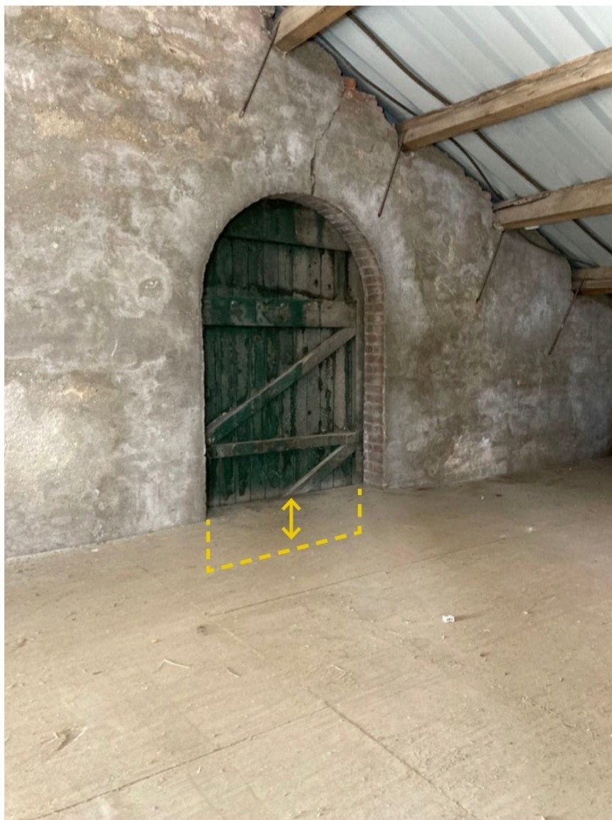
De tussenvloer van de hooizolder ligt iets hoger dan het boven-deurtje in de voorgevel
