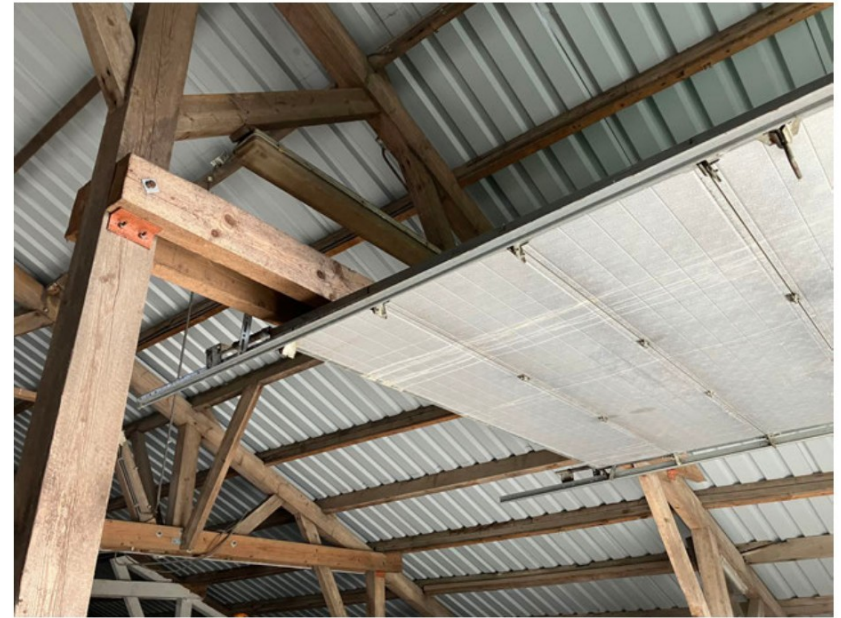
Hulpconstructie t.b.v. de roldeur in de voorgevel
