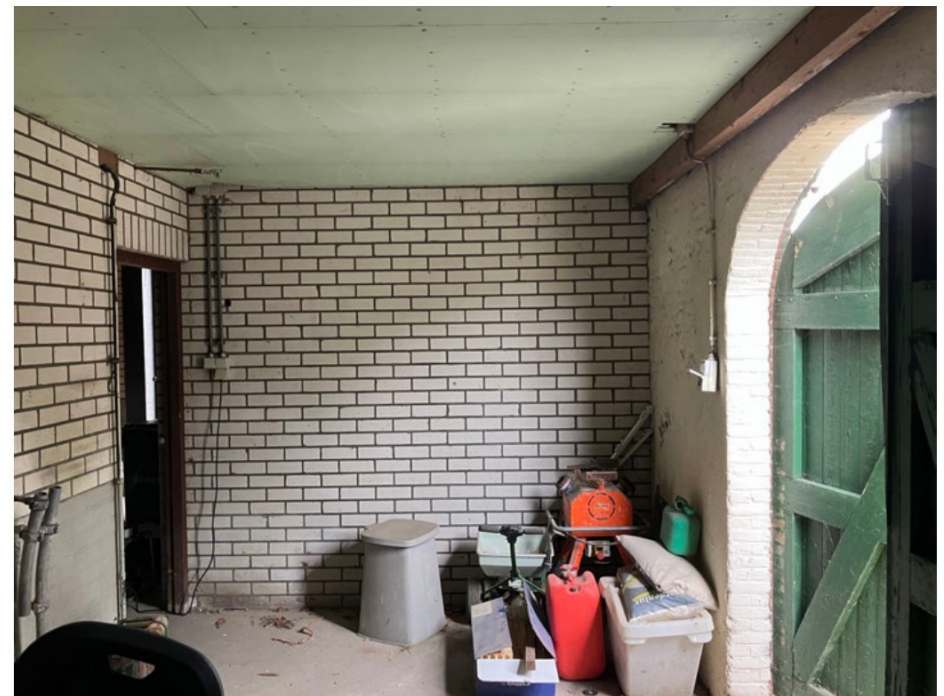
Berging met getoogde buitendeur in de voorgevel
