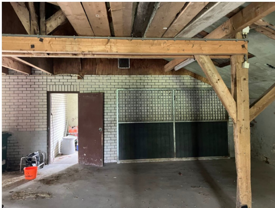
Scheidingswand tussen paardenstal en bergingen
