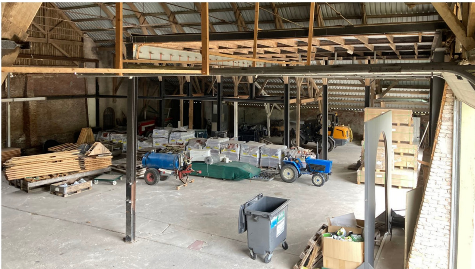
Interieur middentravee, met betonvloer
