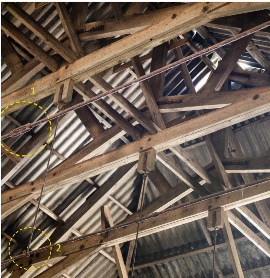
Trekstang met wartel (1), ondersteuning trekstang (2) (foto 2017)
