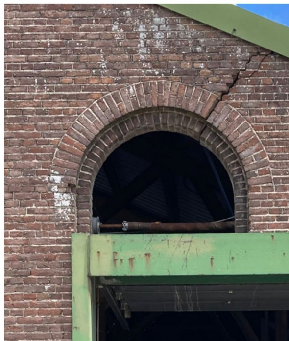
Restant luikopening met steensponning
