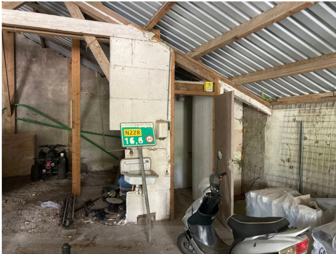
Interieur rechter travee, restanten recente toiletruimte
