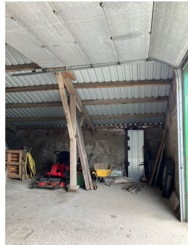
Interieur rechter travee, betonvloer
