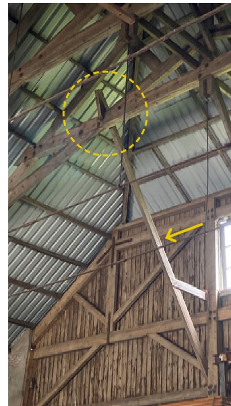
Hangwerk afgeschoord aan het naastliggende spant
