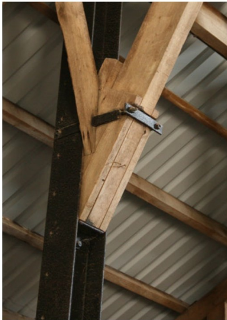
Aansluiting schoren op kolom
