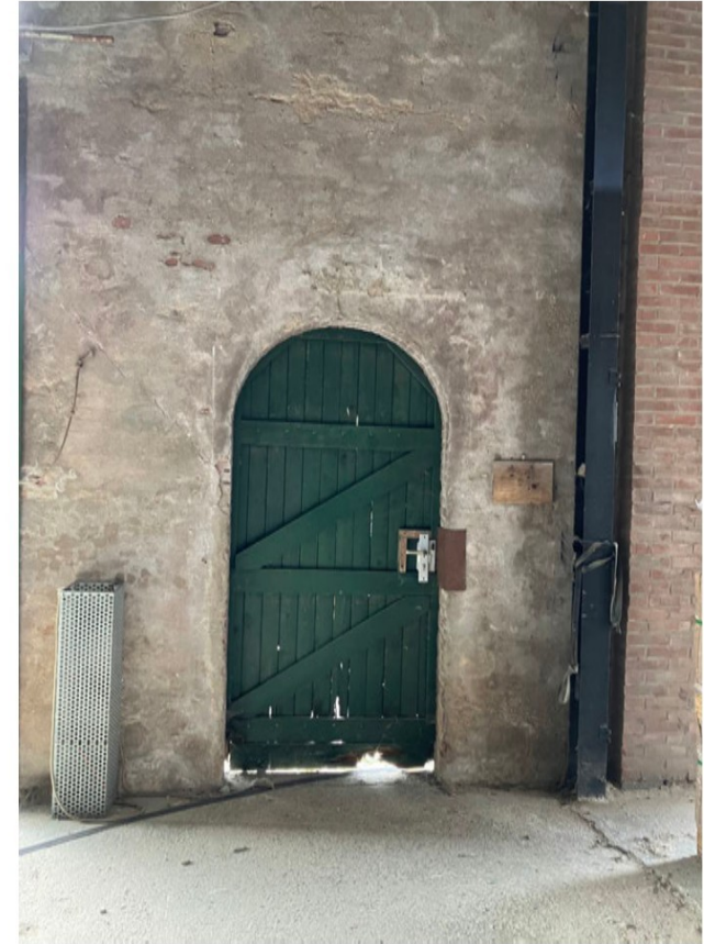
Interieur rechter travee, voorgevel
