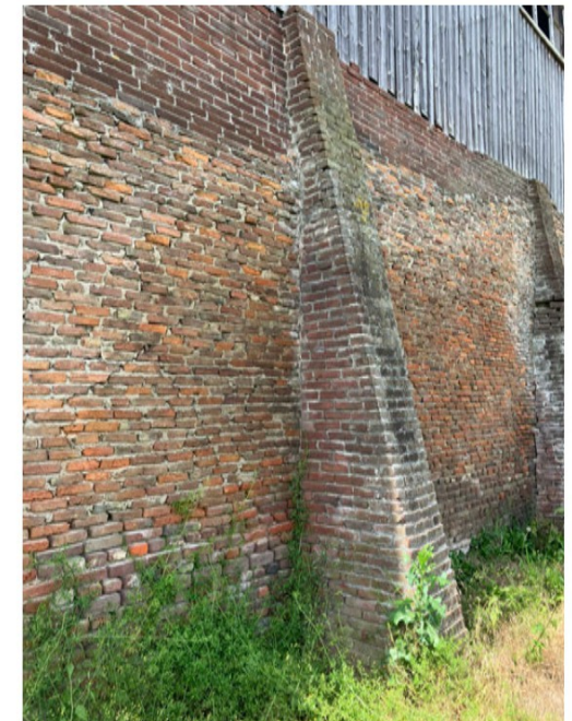
Baksteen invulling middentravee met steunberen
