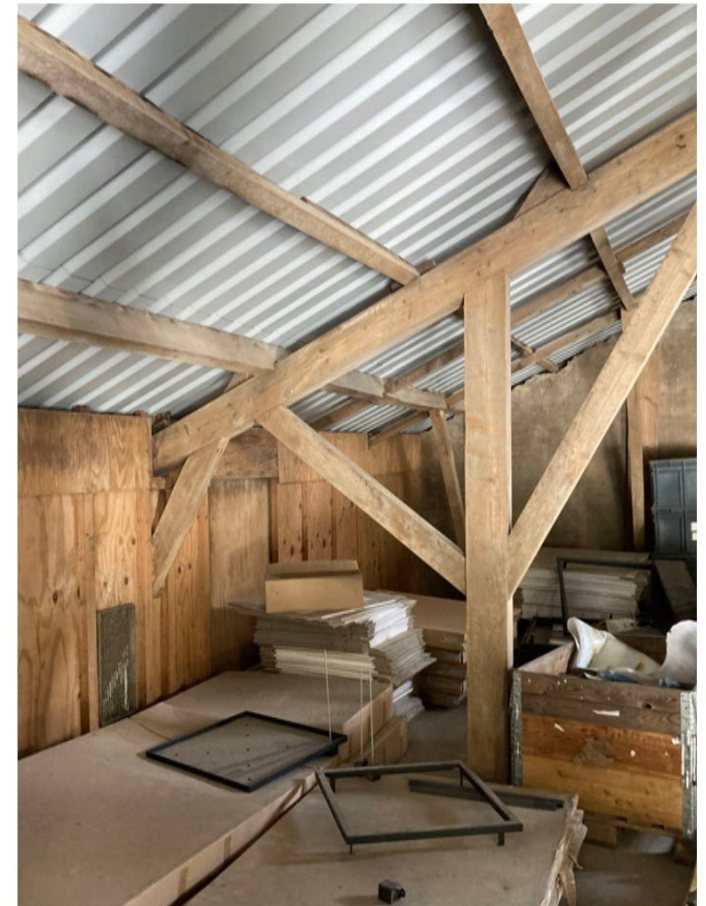
Constructie turfloods (linker travee), boven de (se-cundaire) verdiepingsvloer
