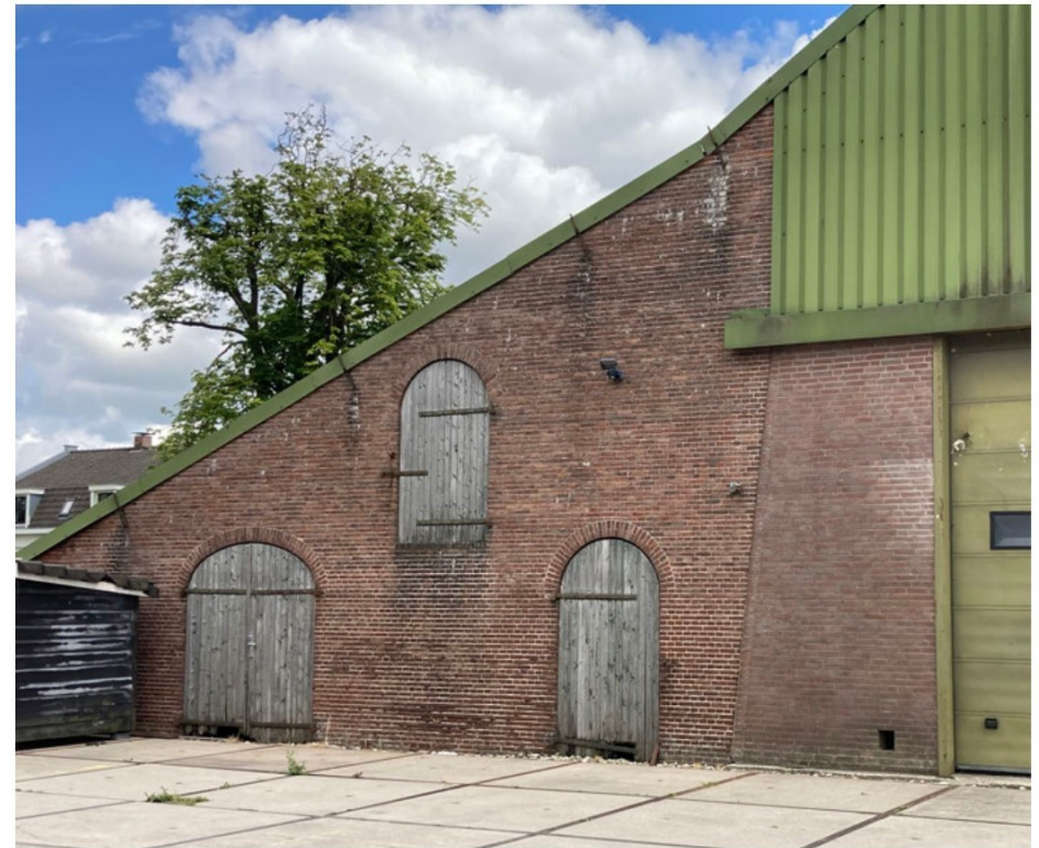
Voorgevel, linker travee
