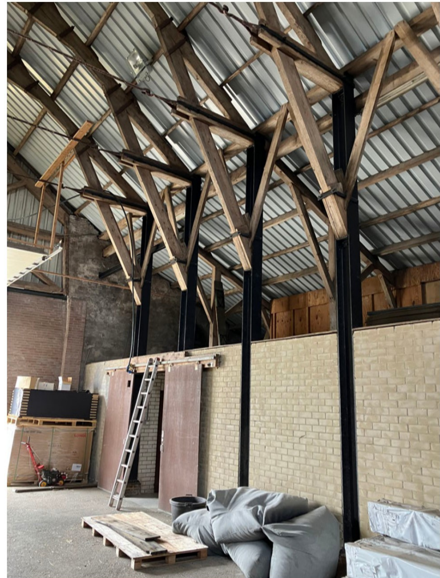
Scheidingswand met daarboven de hooizolder
