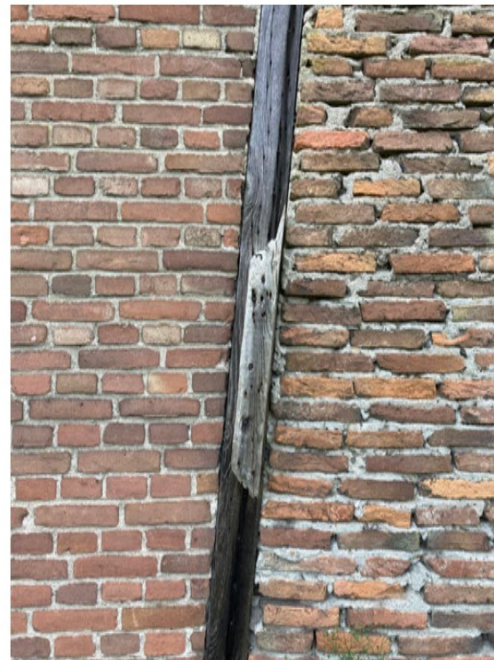
Overgang origineel werk (links) naar latere invulling (middentravee)
