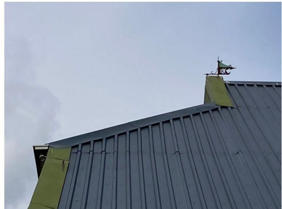
Recente dakbedekking, bovenin één van de originele windvaantjes
