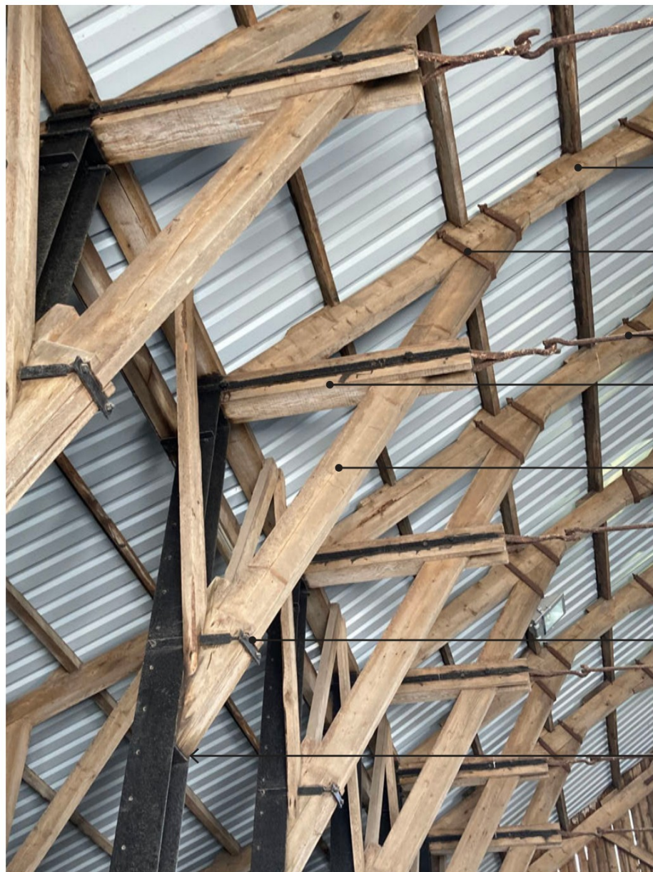
Aansluiting springwerk op kolommen
