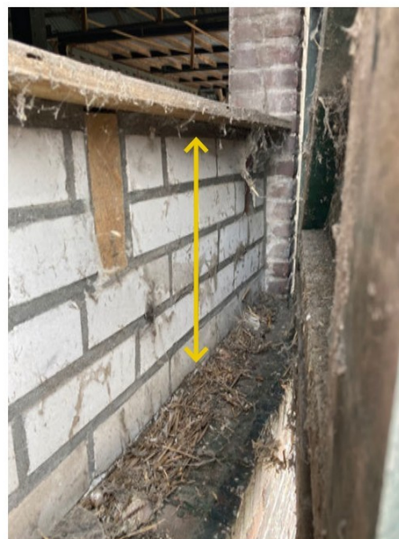
Niveauverschil van buiten gezien
