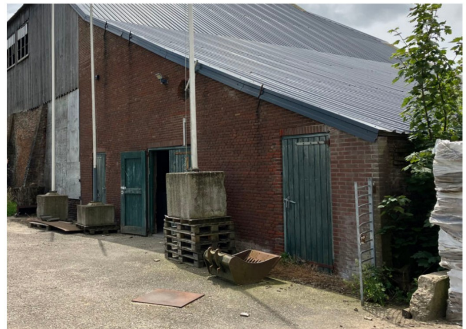
Achtergevel, rechter geveldeel
