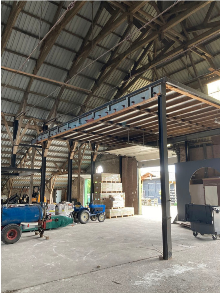
Staalconstructie bij voorgevel t.b.v. tussenvloer
