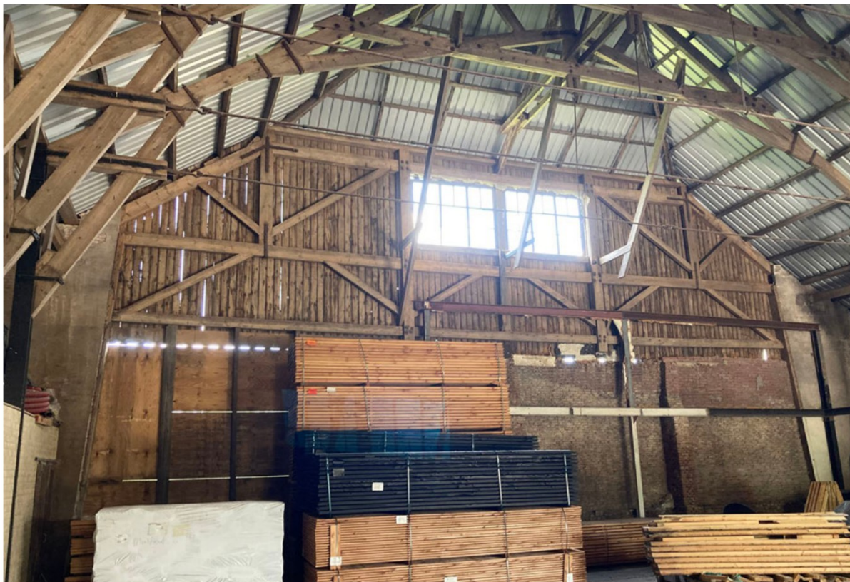
Overzicht hangwerk (achtergevel)
