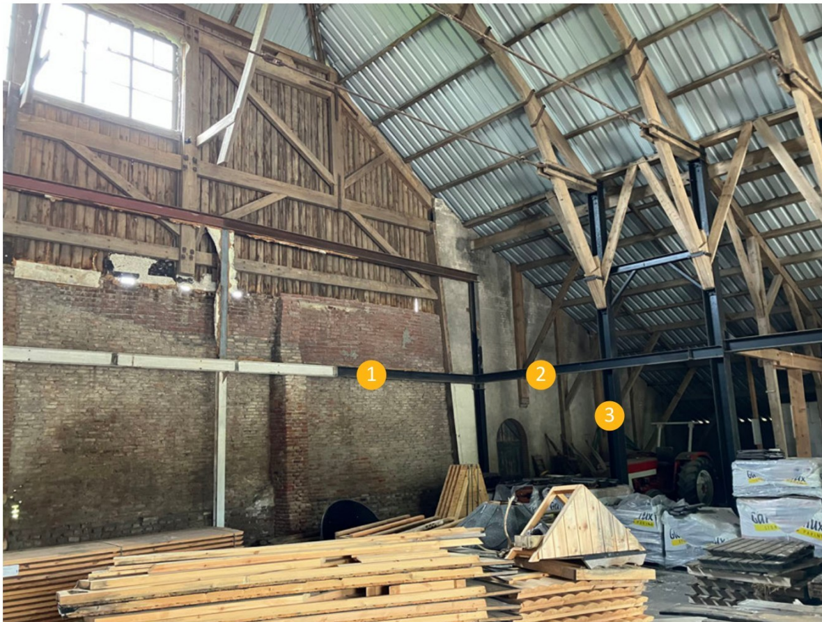
Stalen hulpconstructie tegen achtergevel, verbonden aan de originele kolommenstructuur
