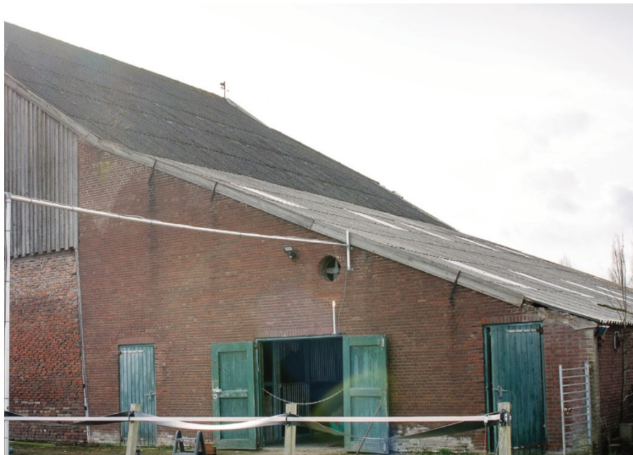
Rechter geveldeel met drie deuren (foto 2017)
