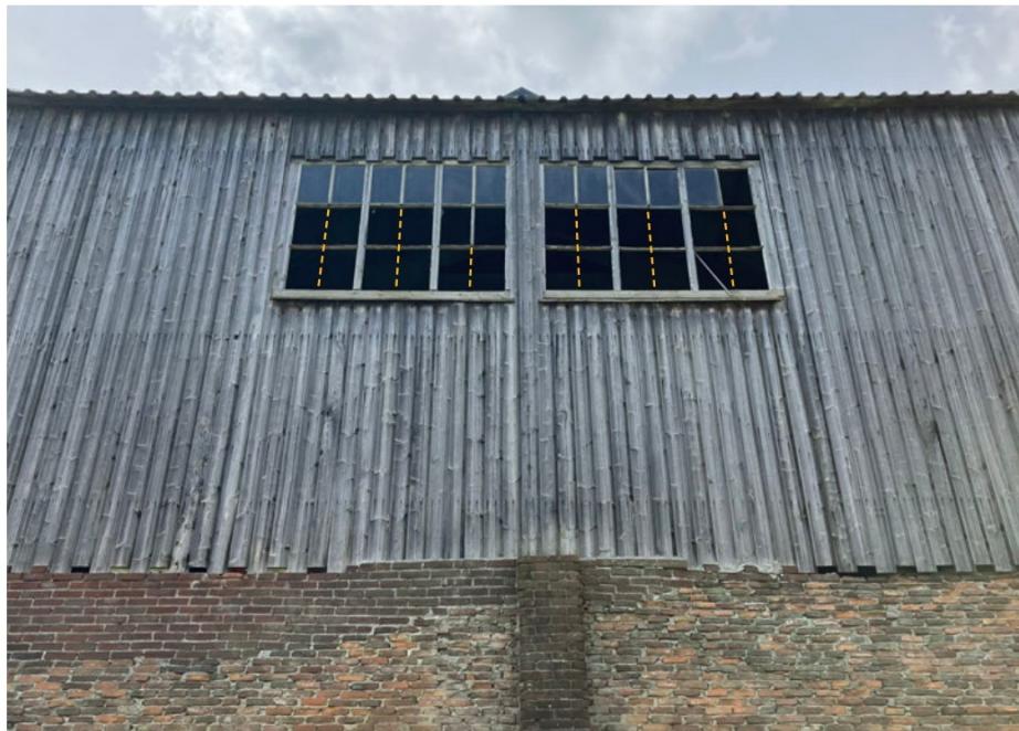
Houten gevelbetimmering met (restanten van) vensters
