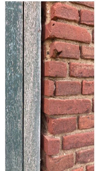
Middelste deur ingezaagd
