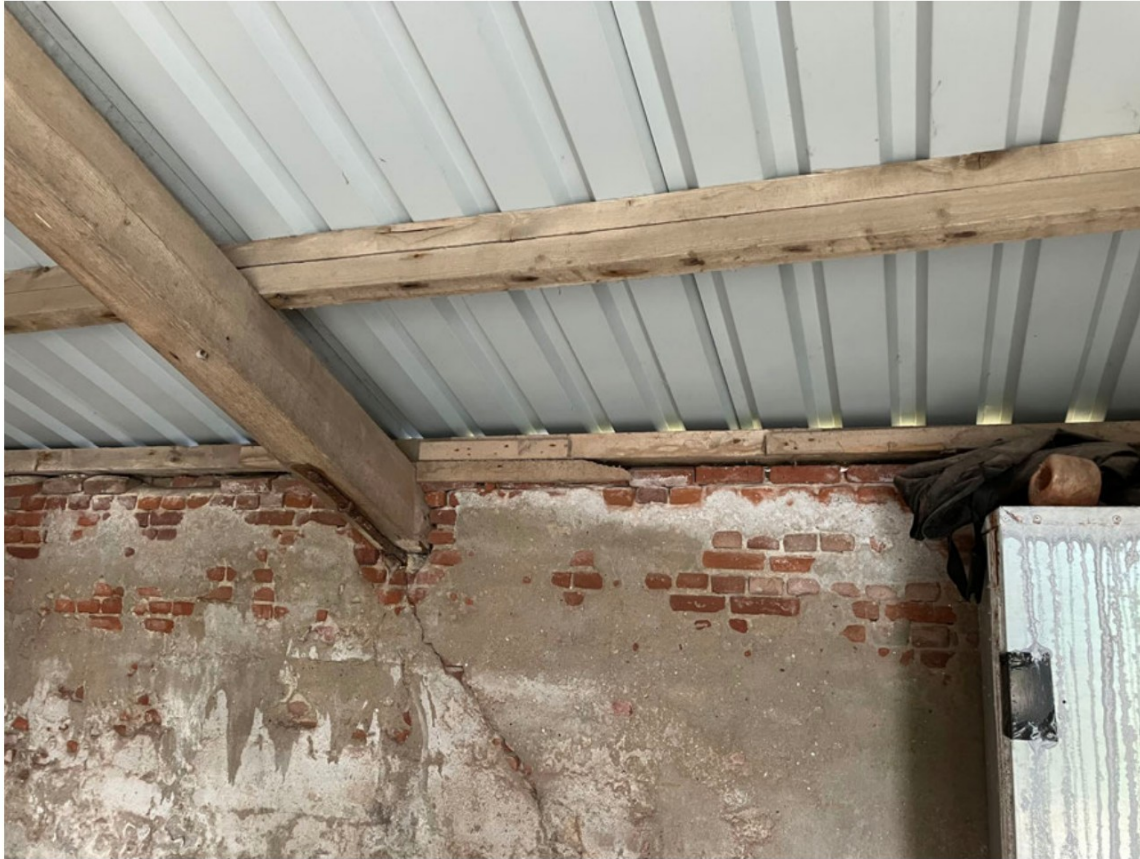
Interieur rechter travee, zijgevel
