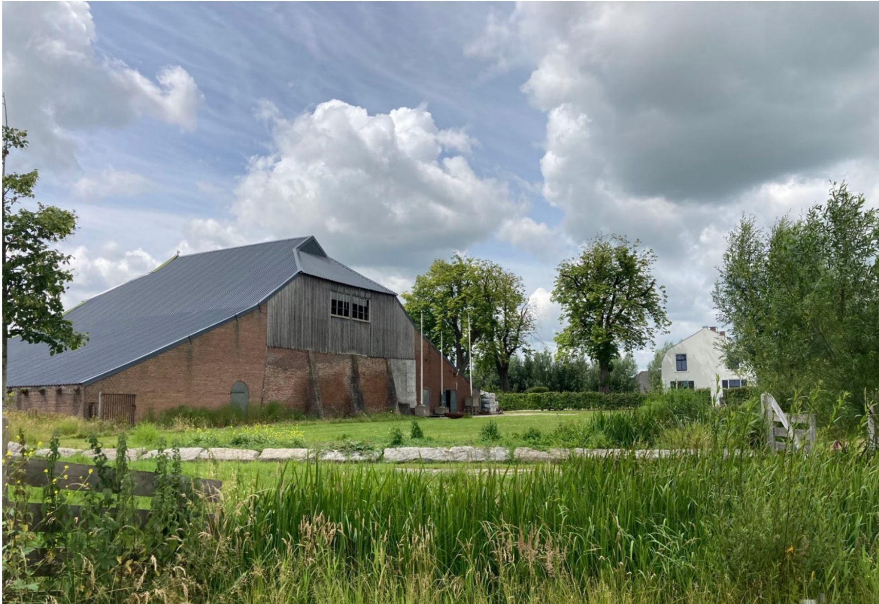
De steenovenschuur en de bazenwoning van de voormalige steenfabriek IJsseloord
