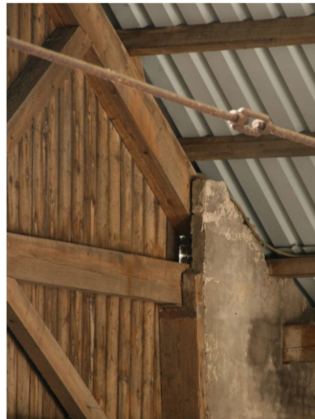
Oplegging metselwerk en houten staander
