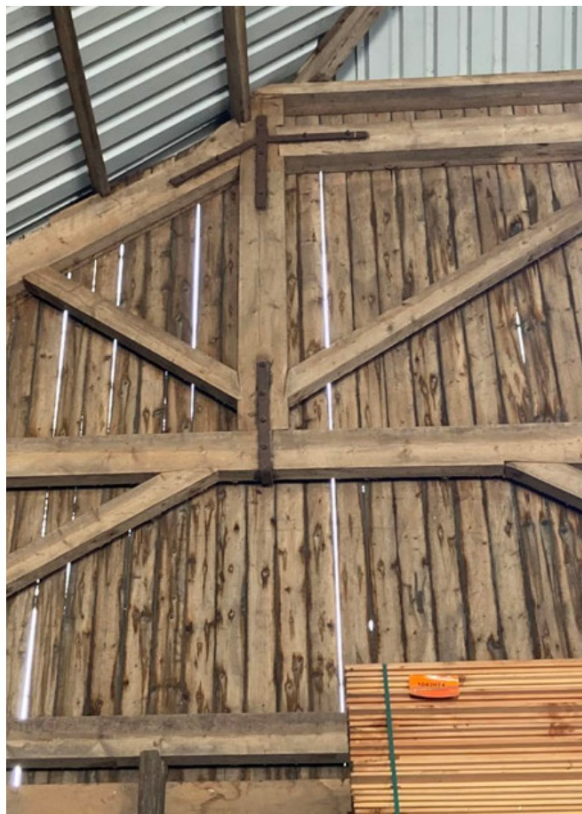
Verbindingen met stalen strippen en beugels, schoren gekeept en gespijkerd
