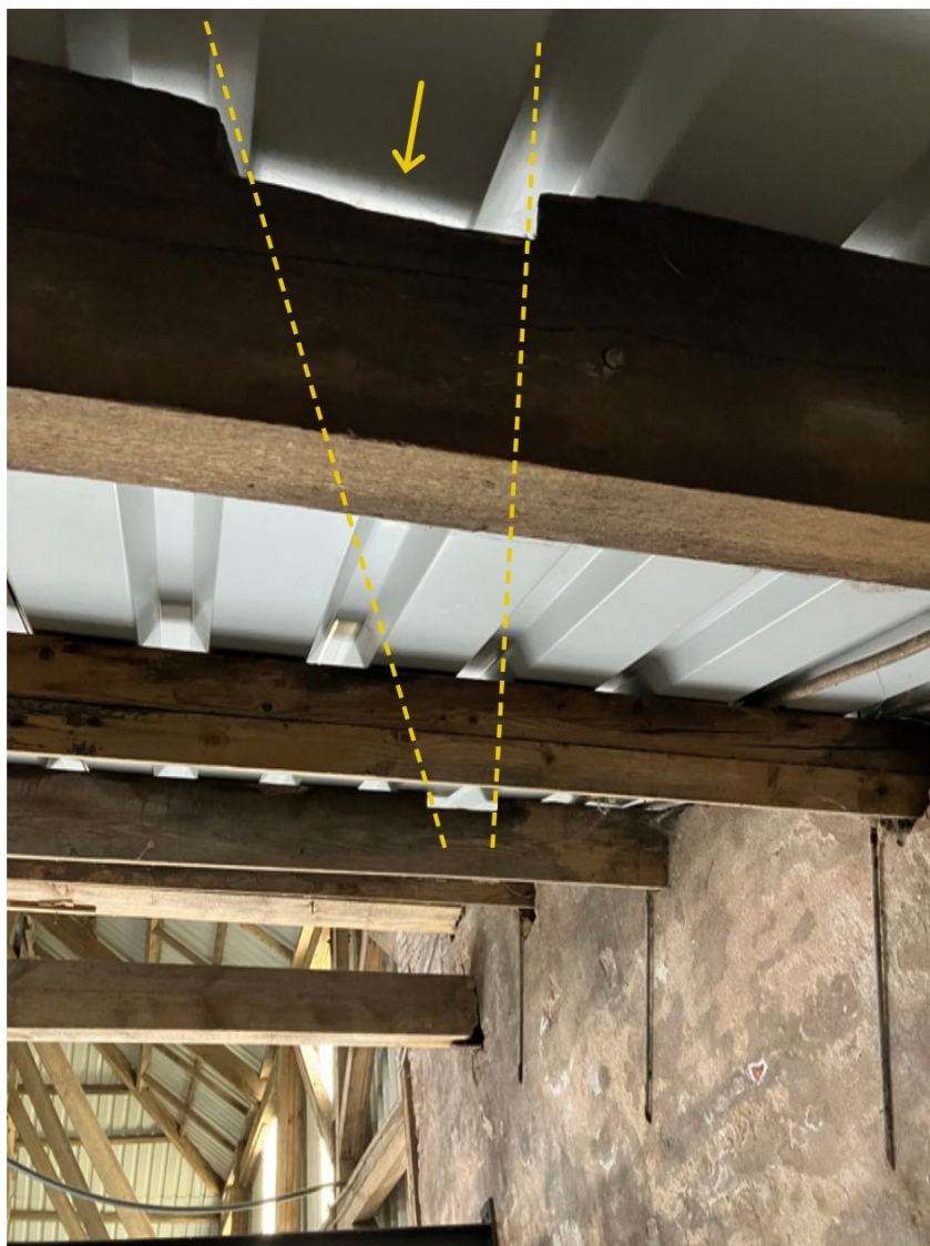
Bouwspoor van een verwijderd windverband (inkepingen in een schuine lijn over de originele sporen)
