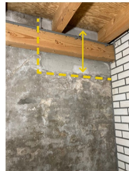
Niveauverschil van binnen gezien
