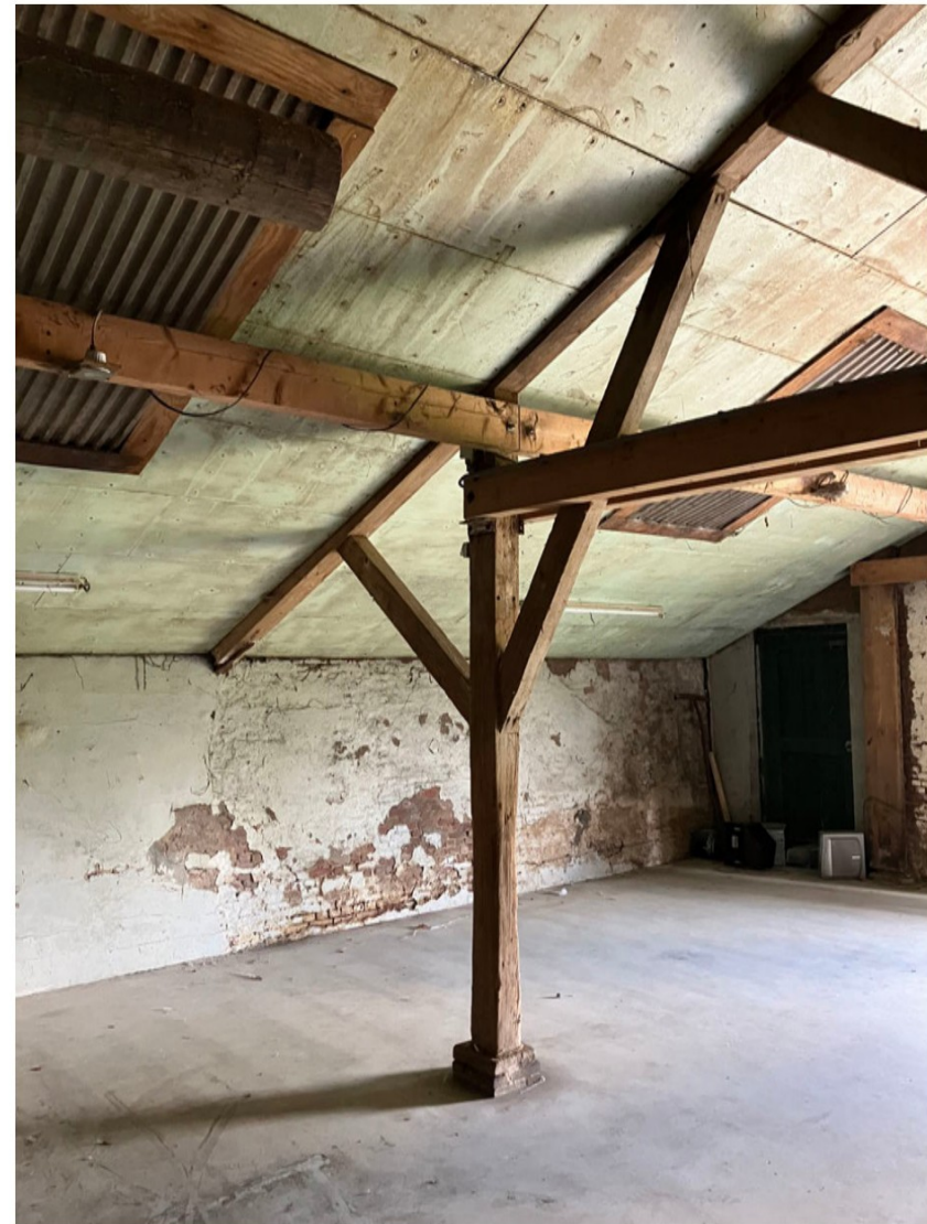
Constructie turfloods (linker travee)
