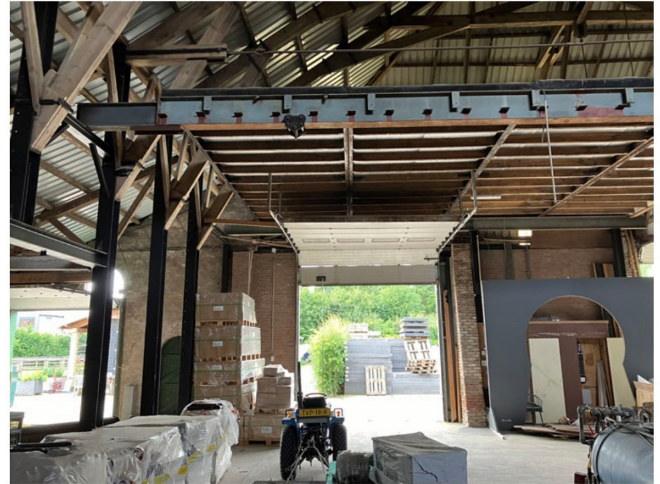
Interieur middentravee, richting voorgevel
