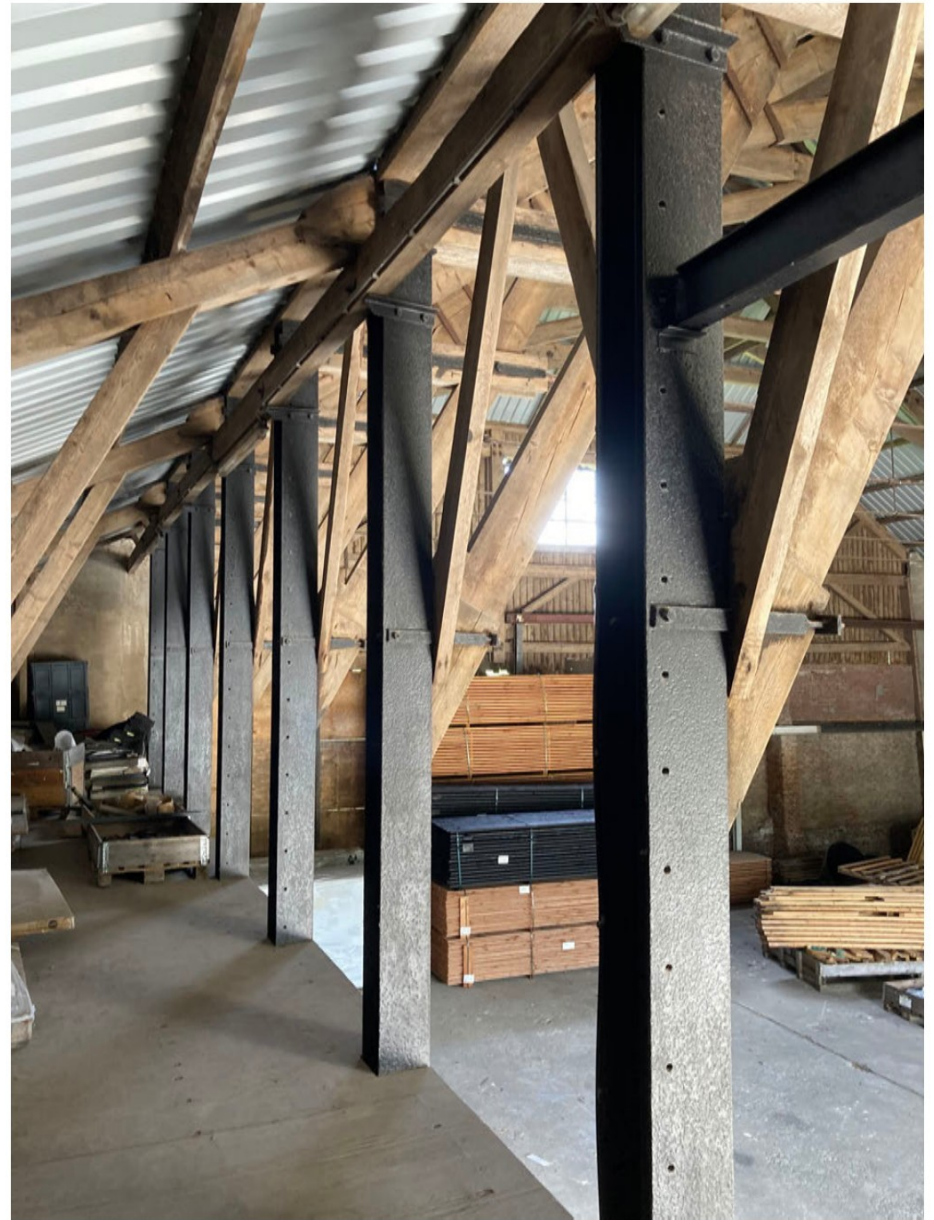
Reeks stalen kolommen (breedflensprofiel IPB22)
