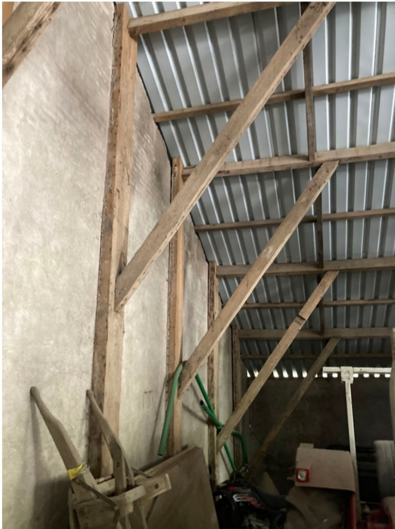
Hulpconstructie rechter travee
