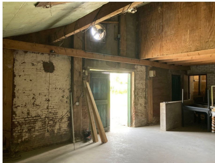
Interieur voormalige paardenstal, achterdeur en afgetimmerde hooizolder
