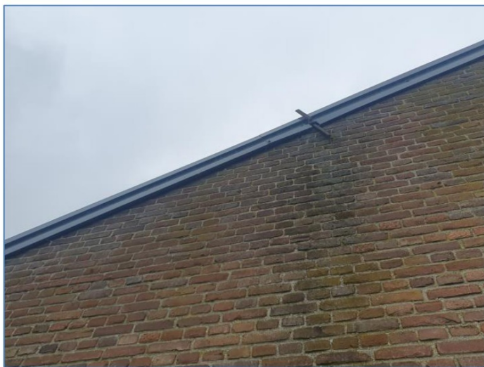
Figuur 7: Stalen boeideel op een muur zonder spouw.
