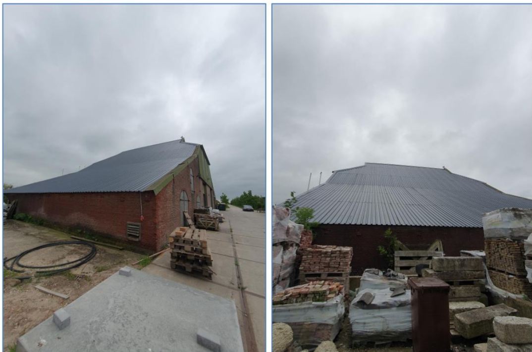
Figuur 2: Foto impressie: links zuid en westzijde; rechts zuidzijde en het stalen dak
