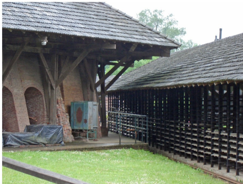
Tot congresruimte ingerichte droogloodsen steenfabriek De Panoven Zevenaer
