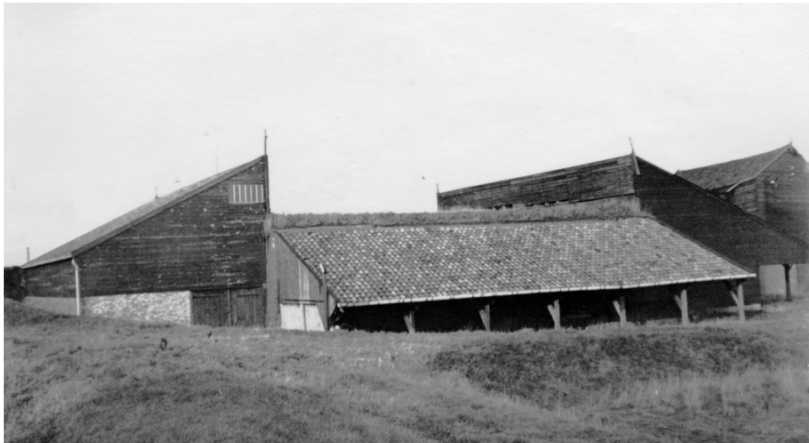
Luifel zoals aangebracht bij steenplaats Gouderak
