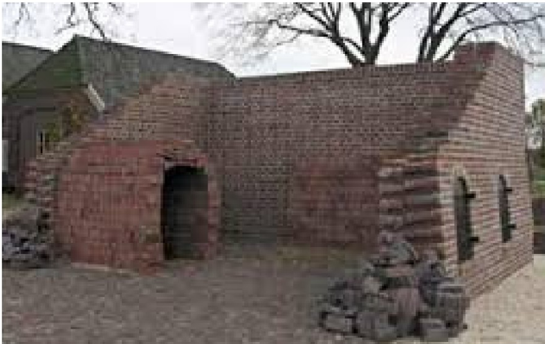
Reconstructie deel veldoven Tichelwerk te Markelo
