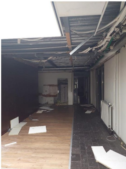
3. metaaldieven hebben in het hele gebouw materialen geroofd. Daarbij zijn dak en wanden zwaar beschadigd. Hierdoor zijn meerdere lekkages ontstaan.
