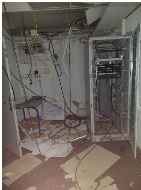
3. metaaldieven hebben in het hele gebouw materialen geroofd. Daarbij zijn dak en wanden zwaar beschadigd. Hierdoor zijn meerdere lekkages ontstaan.
