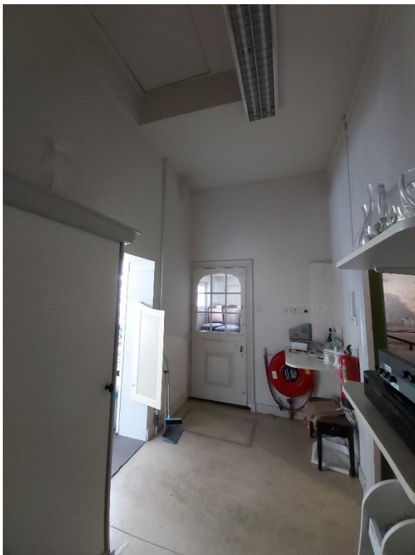
Portaal gezien naar de achtergevel met vermoedelijk historische achterdeur en linksboven de raveling in het plafond waar vroeger de trap zat.
