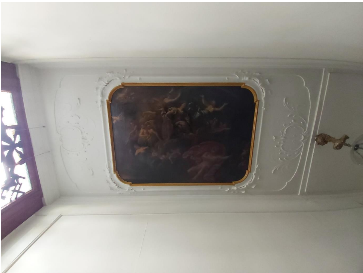
Plafond met rococostucwerk met schildering op doek, rechts de rand in het plafond waar vermoedelijk tot 1855 een muur heeft gestaan.
