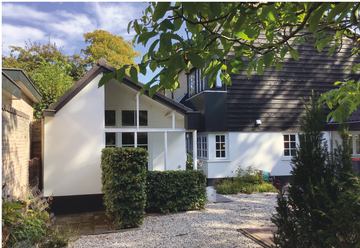
foto 5 _ Zijaanzicht van de bestaande situatie, vanaf de achteringang perceel (via recht van overpad)
