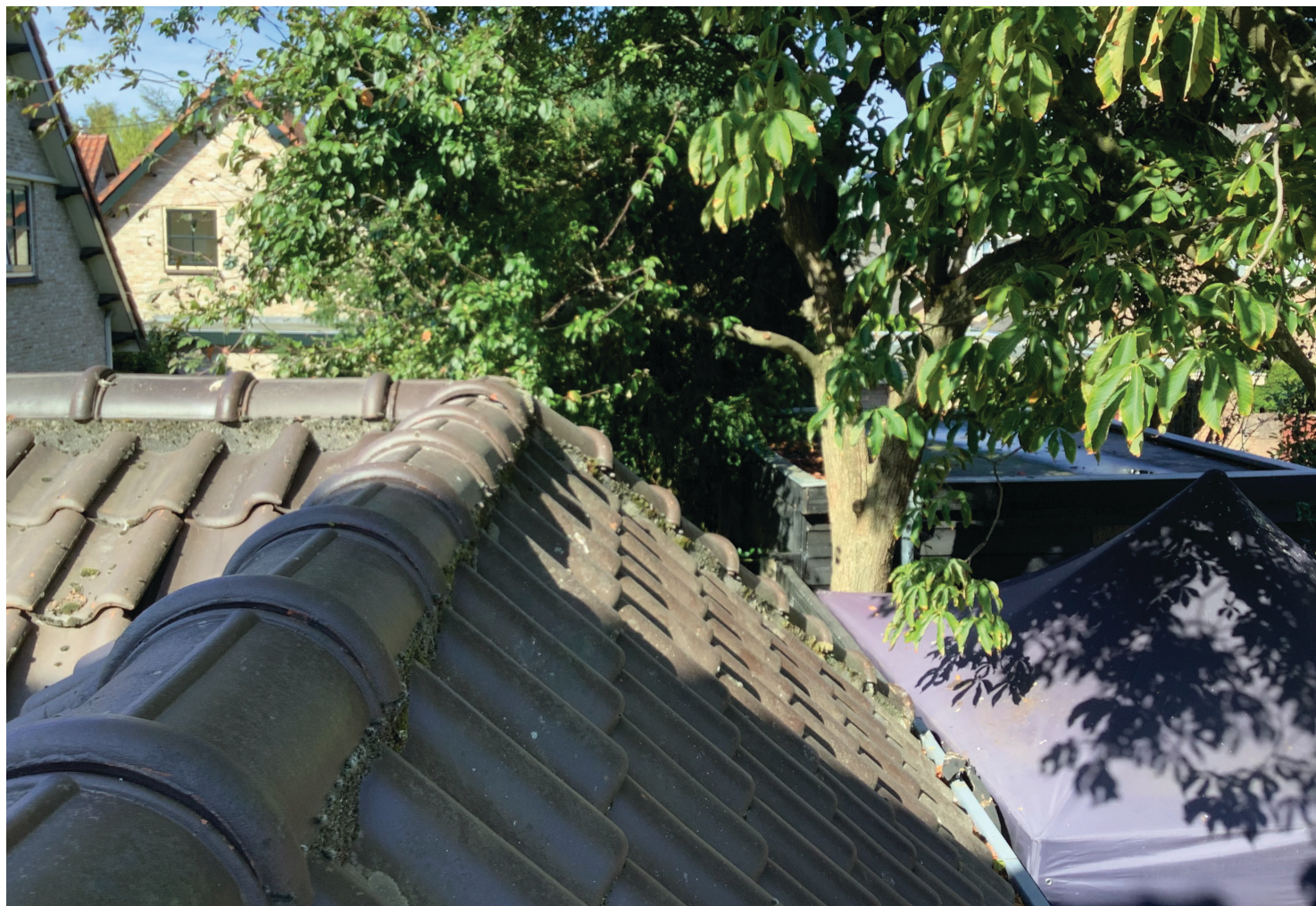
foto 10 _ Dak van achterste gebouwdeel, kijkend richting het westen (achtertuin 5.1.2e rechts in beeld)
