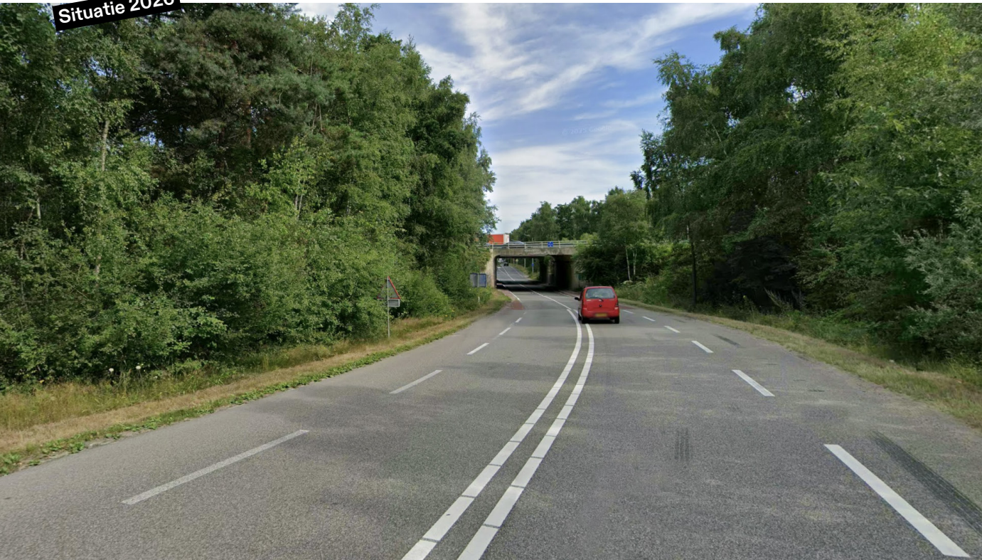
Huidige onderdoorgang Erica-A58
