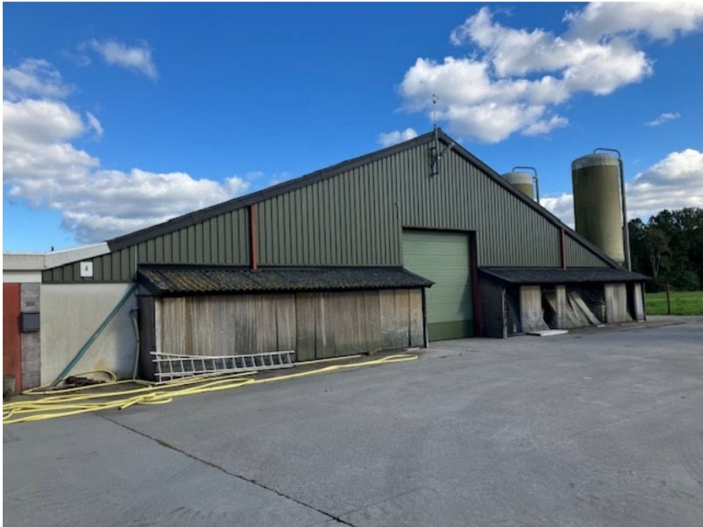
• Afbeelding 11: Voorgevel achterste te slopen stal
