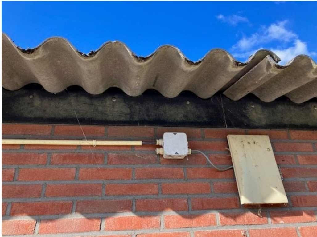
• Afbeelding 7: Onderzijde golfplaten, naadloos dicht gemaakt
