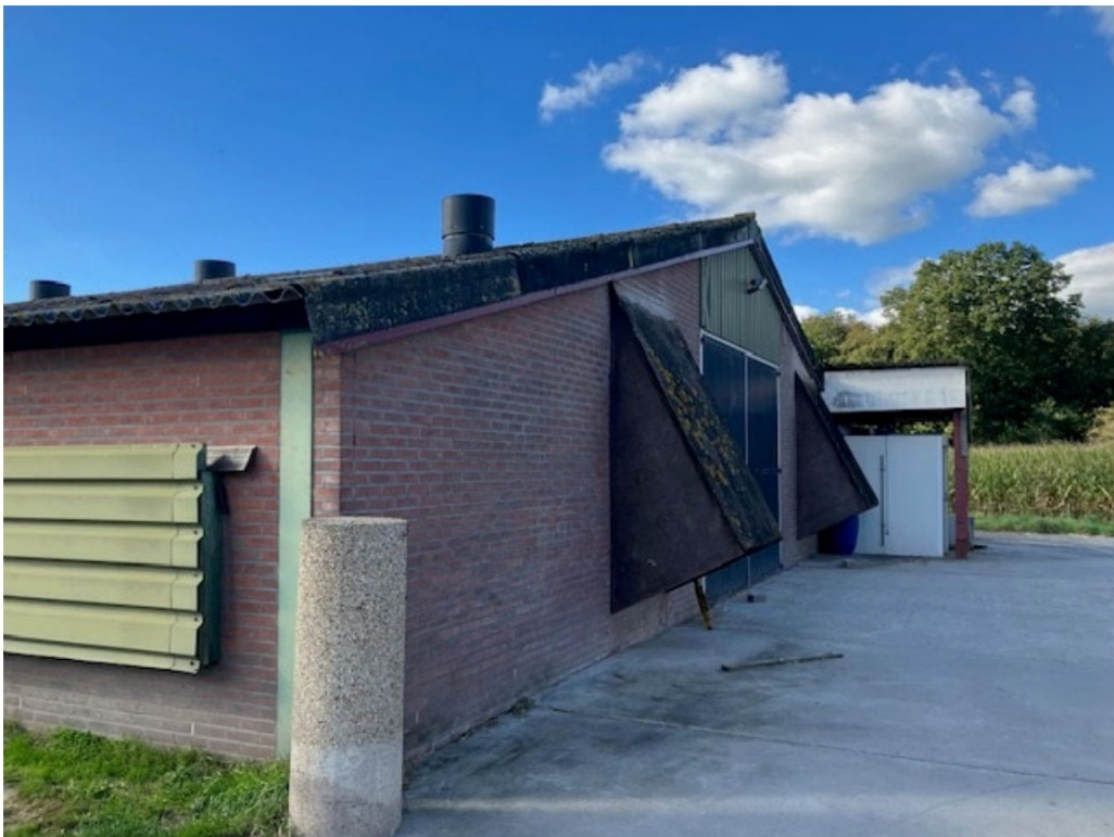
• Afbeelding 12: Achtergevel voorste te slopen stal
