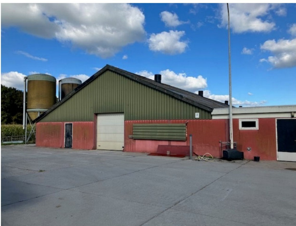
• Afbeelding 10: Voorgevel achterste te slopen stal
