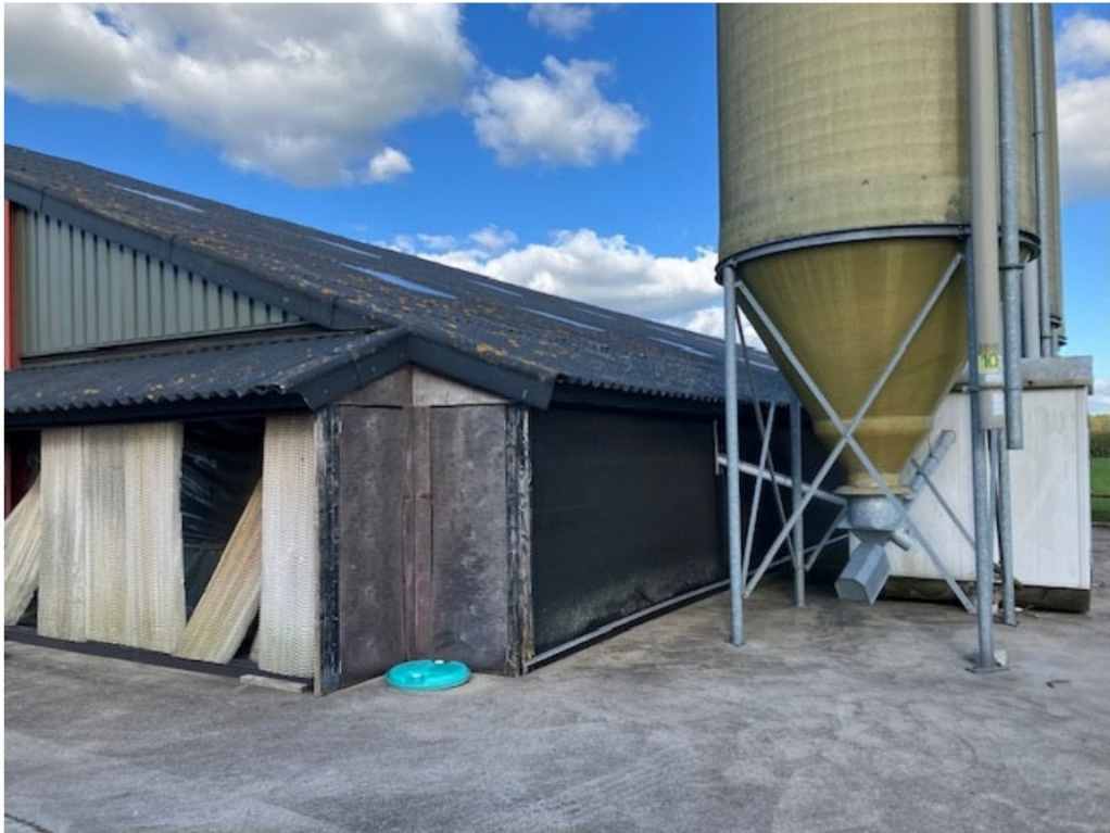
• Afbeelding 13: Achtergevel achterste te slopen stal
