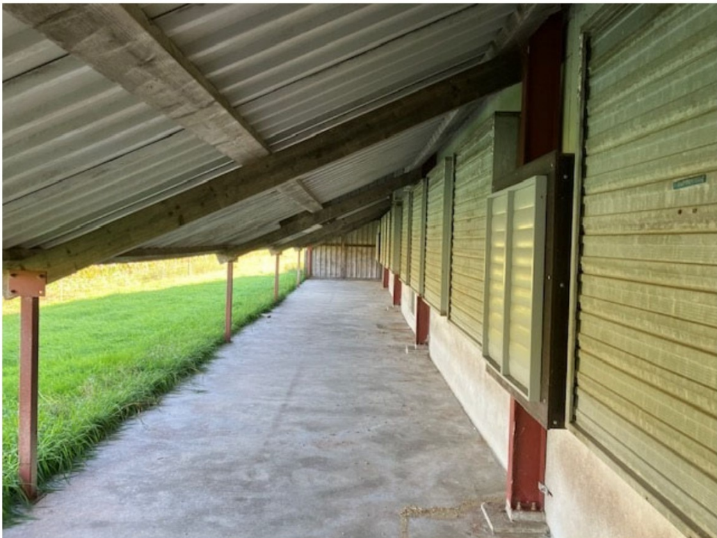
• Afbeelding 18: Uitlaatventilatoren
