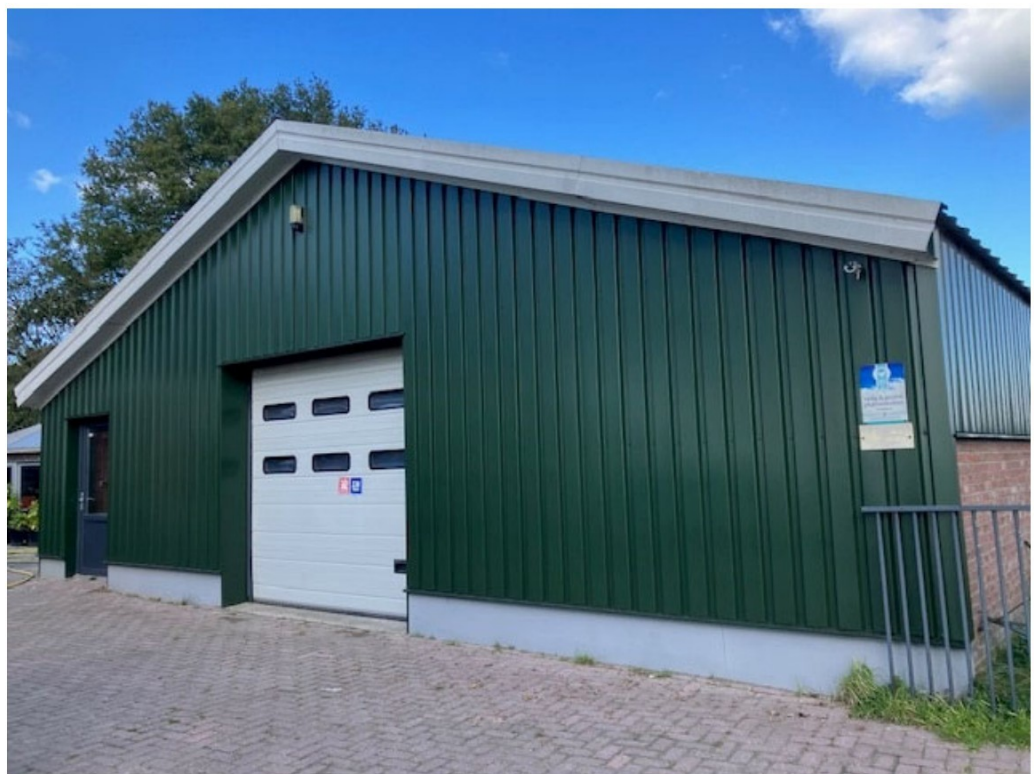
• Afbeelding 22: Loods die behouden blijft
