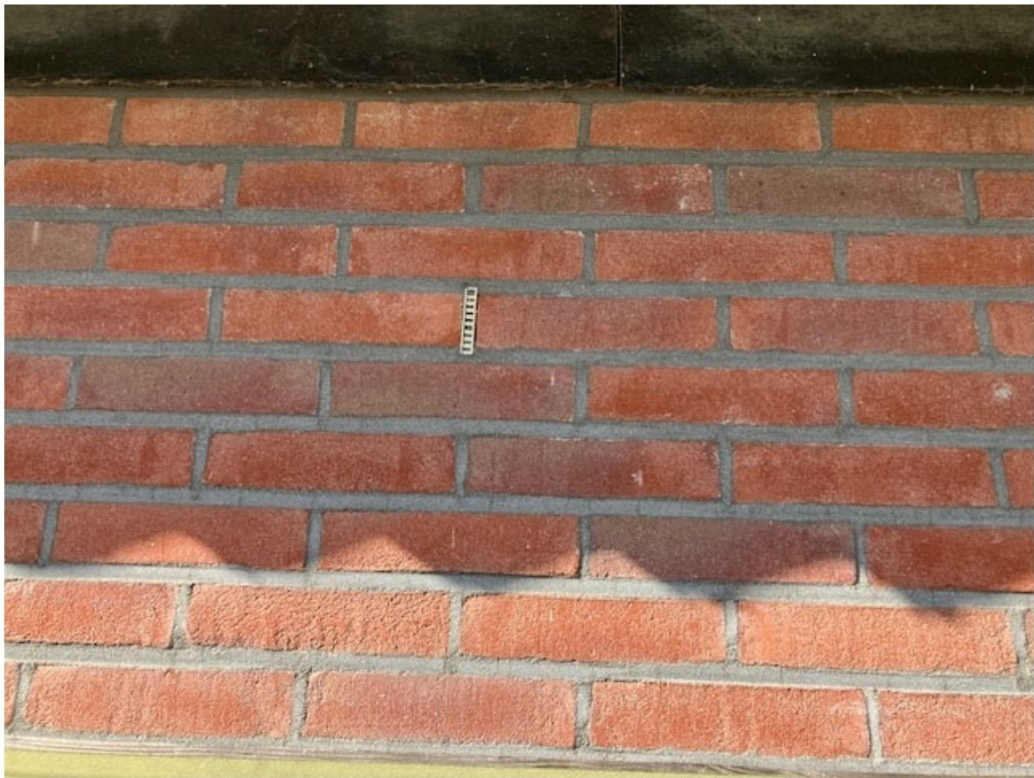
• Afbeelding 21: bijenbekjes in alle open stootvoegen
