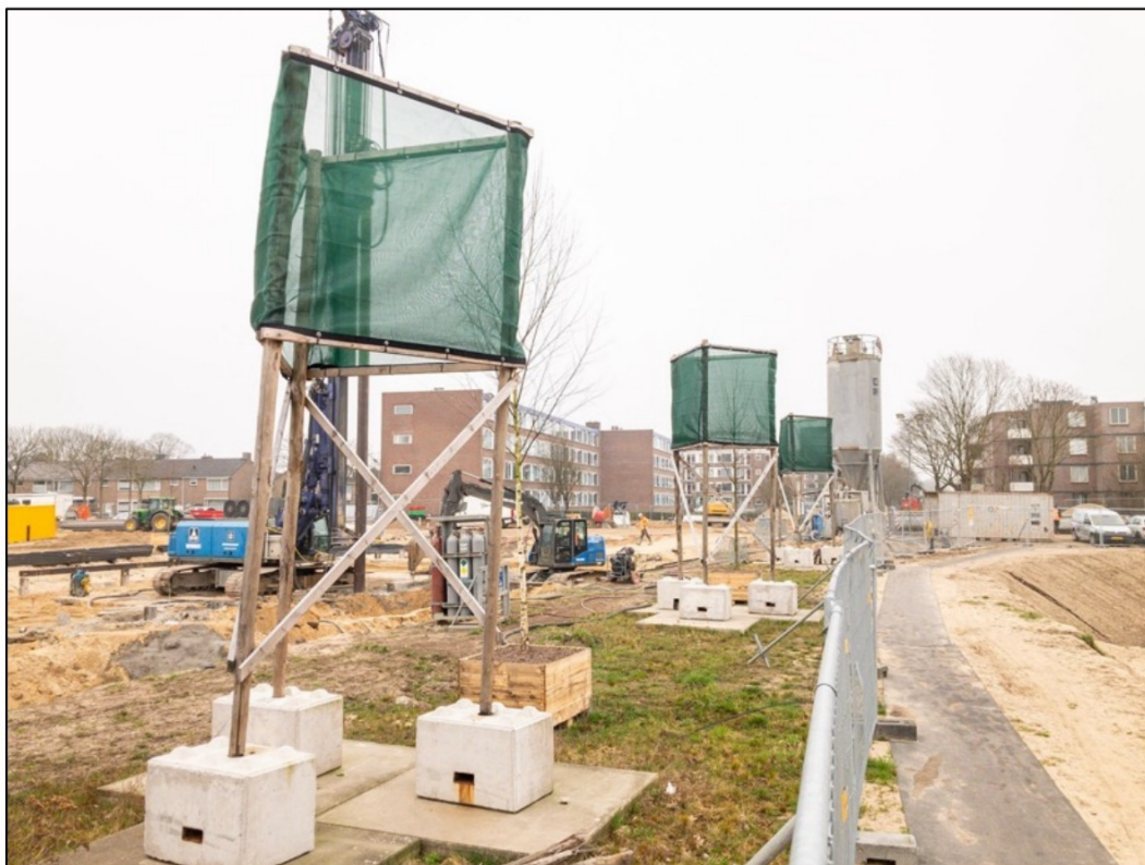
Figuur 4.4 Schermen en bomen in potten op het Nelson Mandelaplein te Nijmegen die tijdens de werkzaamheden aan de hoofdinfrastructuur rond station Goffert als tijdelijke vervanging fungeren van bomen die een verbindingroute voor vleermuizen vervulden. Na afronding van de werkzaamheden worden nieuwe bomen en struiken geplant.
