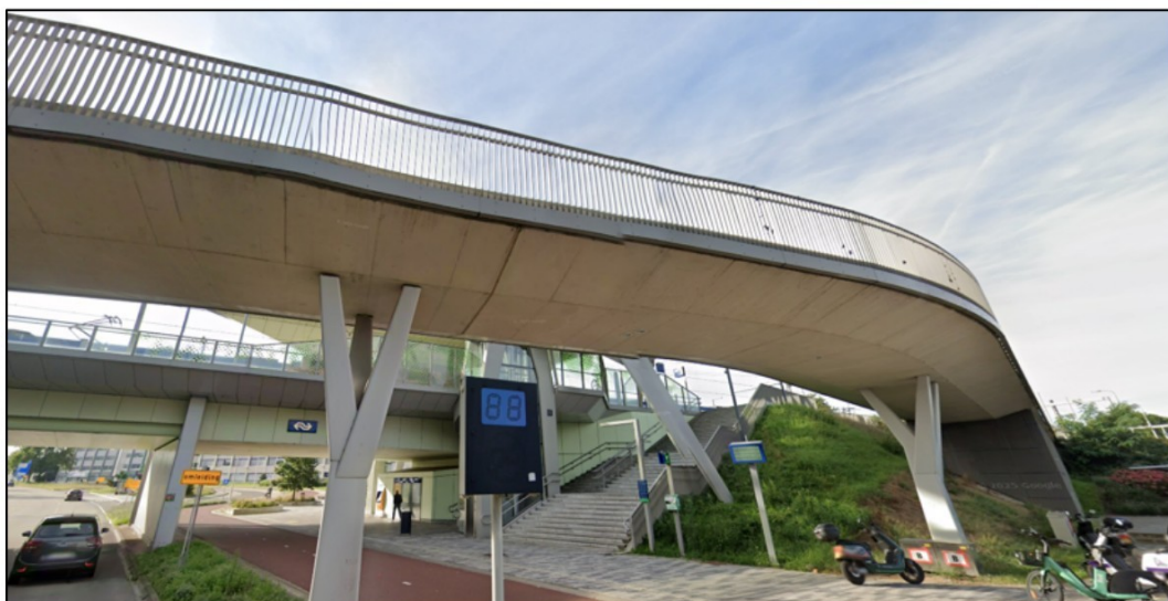
Figuur 4.12b Balustrade langs het fietspad over de Neerbosscheweg. Rechts de fietsenstalling.
