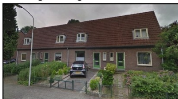
Het betreft een huizenblok van lage woningen met een schuin pannendak en een kleine kapel.
