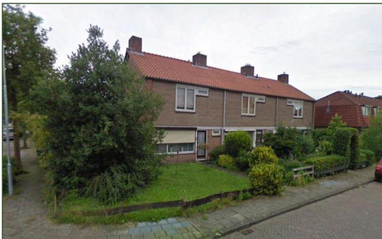
Enkele projectwoningen langs de Zij Waterweg.
