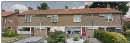
Eengezinswoningen met een schuin pannendak.
