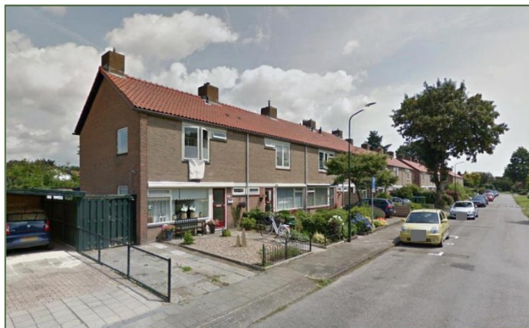
Enkele projectwoningen langs de Dominee Gewinweg.
