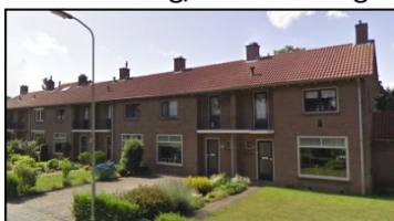
Dit betreft enkele huizenblokken, bestaande uit eengezinswoningen met een schuin pannendak.
