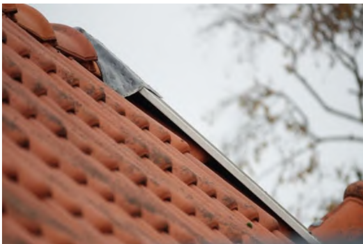
Oostzijde dak woonhuis
