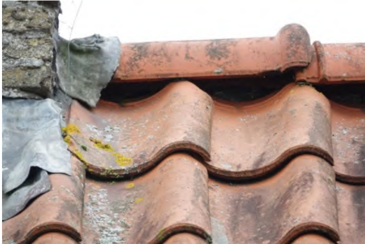
Oostzijde dak woonhuis
