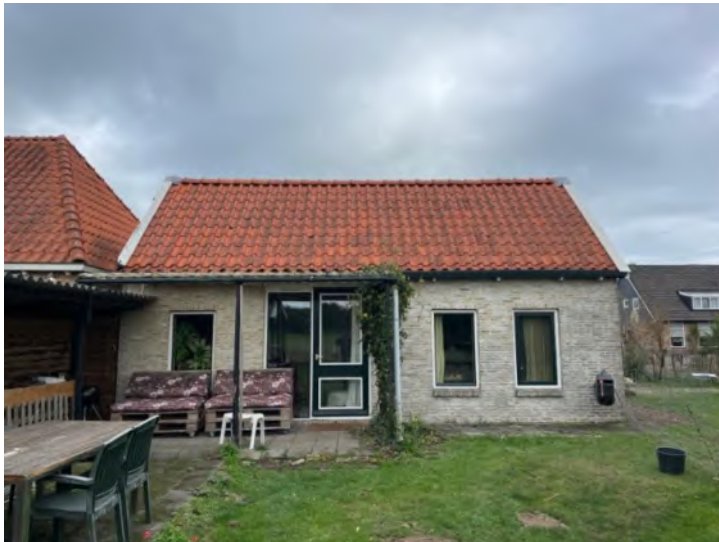
Huidige situatie, het te slopen gedeelte.
