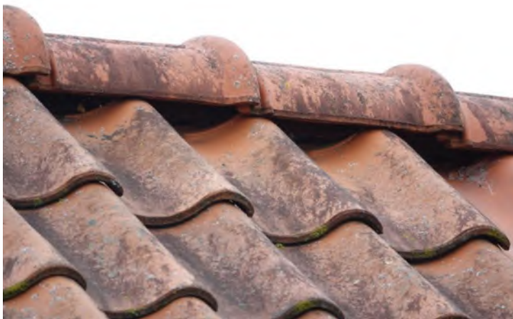
Oostzijde dak woonhuis
