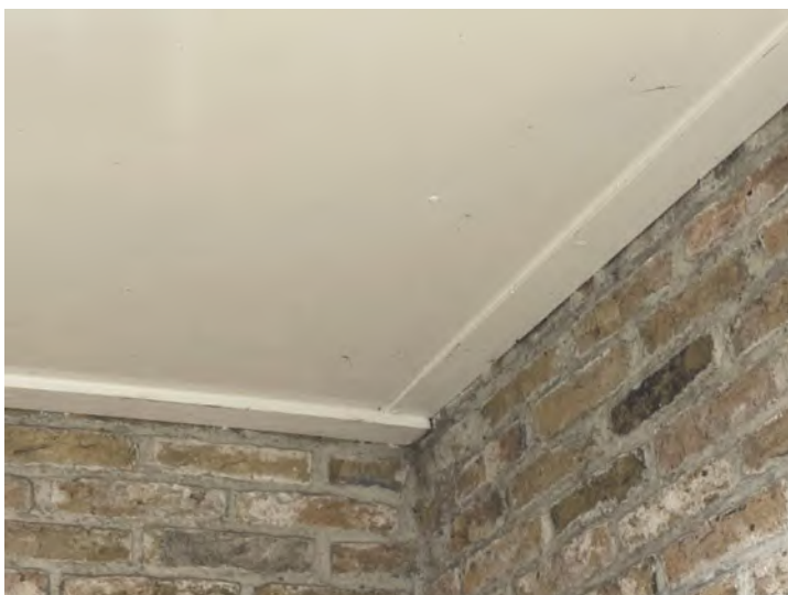
Betimmeringen sluiten goed aan op de muren
