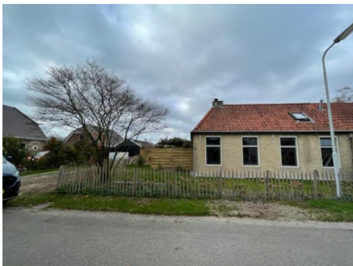
Voorzijde woonhuis, de oostzijde
