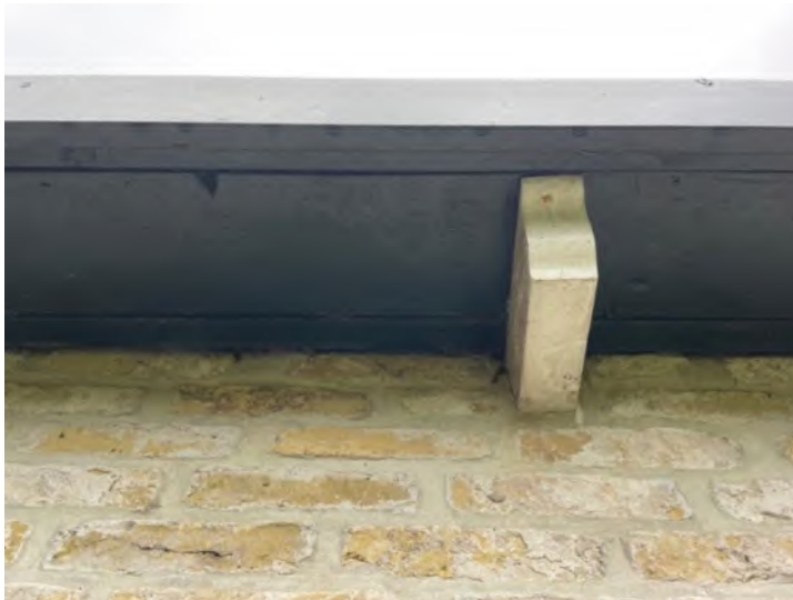
Oversteek dakgoten sluit aan op de muren
