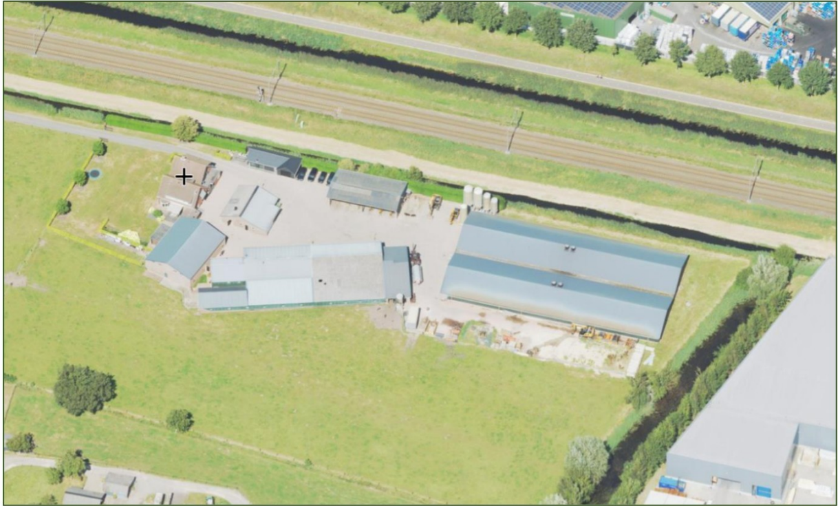
Afbeelding, luchtfoto perceel Kade 15 te Ede (bron: Street Smart)
