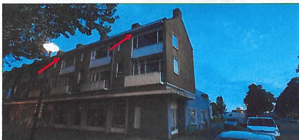
Bebouwing in het plangebied met de twee aangetroffen nesten (rode pijlen) van Gierzwaluwen.
