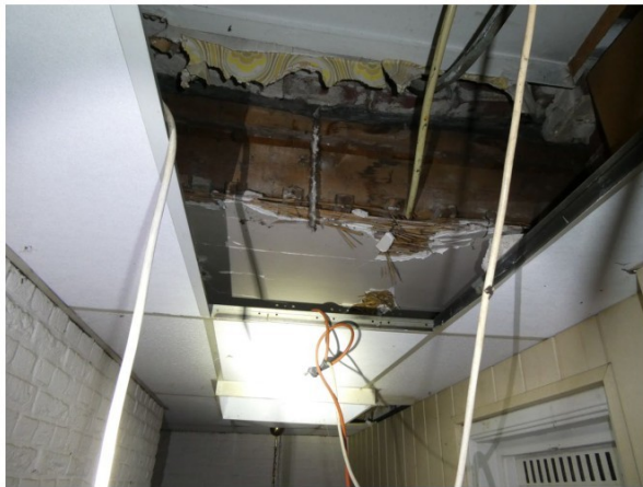
Overzichtsfoto plafond (Gipsplaten en beton)
