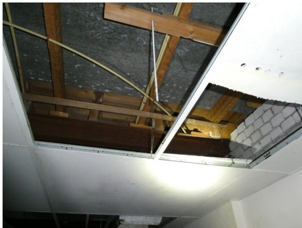
Overzichtsfoto plafond (Systeemplafond en beton)
