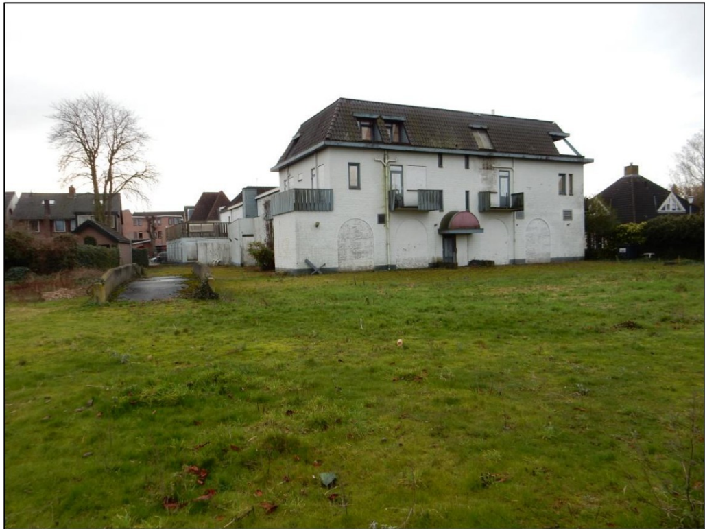
Figuur 2 Fotografische indruk van de noordwestzijde van het hotel en het braakliggende terrein rondom het hotel. Links is tevens de betonnen brug zichtbaar.
