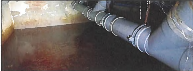
Figuur 6: In de kruipruimtes van de panden staat permanent een laag water, hetgeen leidt tot een hoge vochtbelasting.
