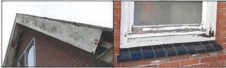
Figuur 5: De panden kampen met rotte kozijnen, gescheurde dakbeschotten en missende dakpannen. Hierdoor ontstaat lekkage en kunnen vocht en tocht het pand binnendringen.
