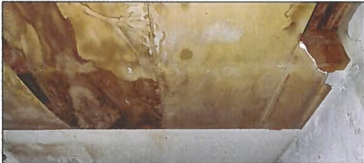
Figuur 6: In de kruipruimtes van de panden staat permanent een laag water, hetgeen leidt tot een hoge vochtbelasting.
