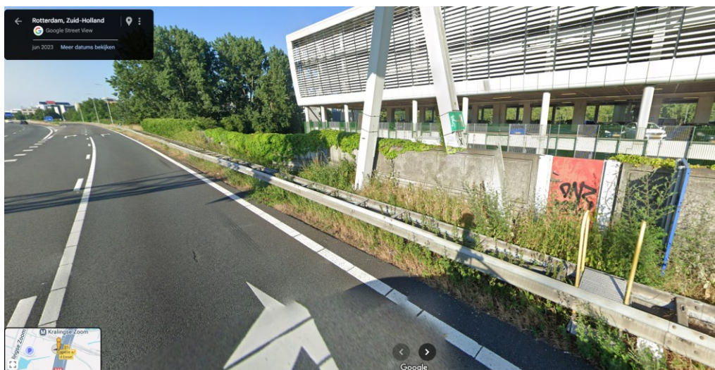
figuur 10: Op 300 meter ten noorden van de planlocatie staat langs de snelweg een betonnen geluidscherm. Daarmee wordt bij een plasbrand afstroming voorkomen en wordt het plasoppervlak indirect verkleind. Een dergelijke wand leidt tot een lagere warmtebelasting in het achterliggende gebied. Afbeelding: Google Street View d.d. juni 2023.
