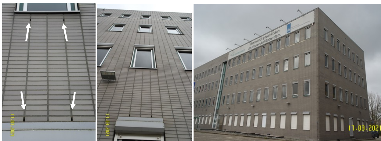
Afbeelding 16 t/m 18: Gemetselde muren met spouw en open stootvoegen bij bijna alle raampartijen
