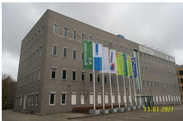
Afbeelding 11: Zuid- en oostzijde kantoorgebouw
