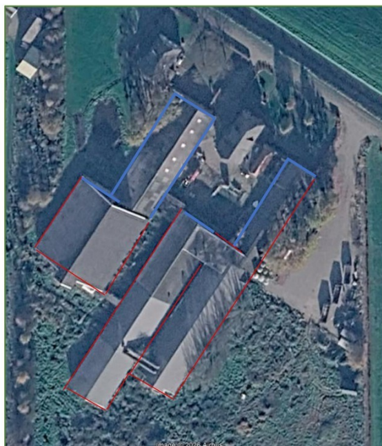
Figuur 5: overzicht van de te slopen schuren. Rood omlijnd de schuren/wanden bestaand uit damwanden zonder spouw, ongeschikt voor vleermuizen.
