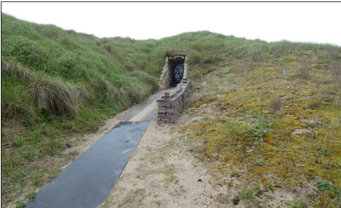
Figuur 10: De nooduitgang van de munitiebunker.
