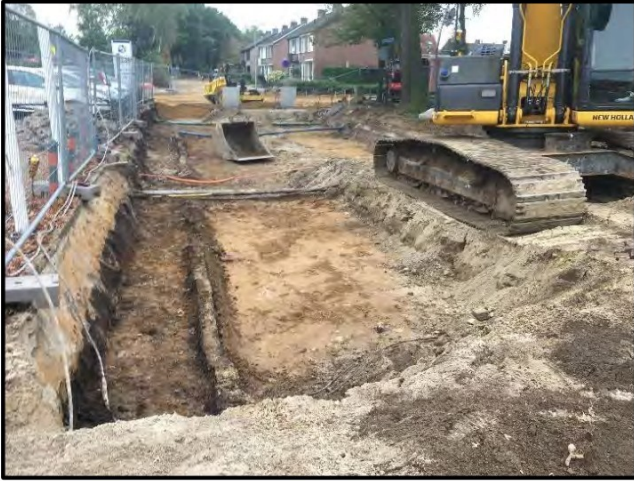
Foto 3: ontgraving in cunet De Mortel
