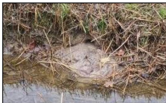
Afbeelding 5: Hol in sloottalud
