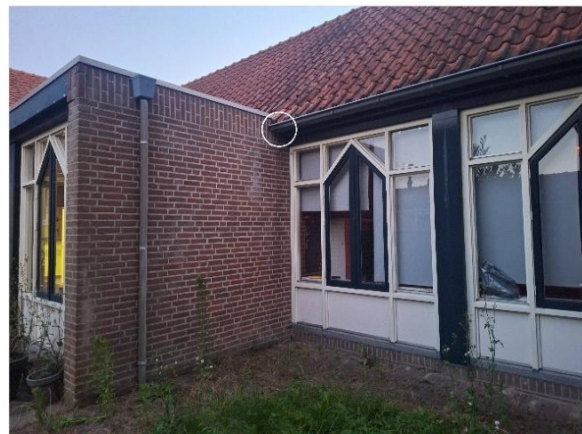
Figuur 3.6 Zomerverblijfplaats gewone dwergvleermuis in een opening van een verrot boeibord.
