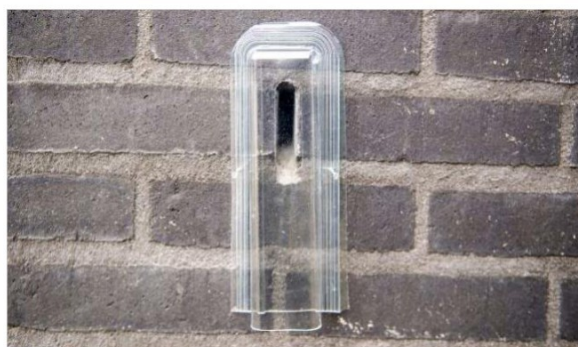
Figuur 7.3 Voorbeeld ongeschikt maken bebouwing door exclusion flap over open stootvoeg.
