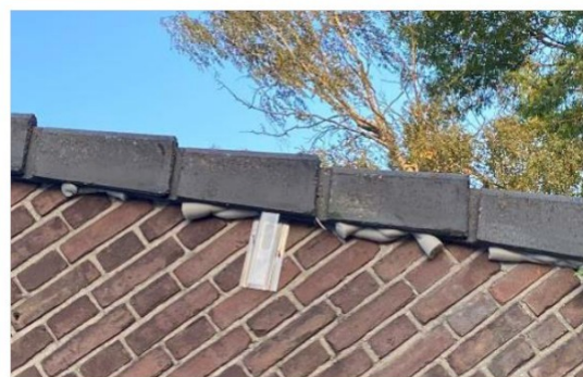
Figuur 7.4 Voorbeeld ongeschikt maken bebouwing door exclusion flap tegen dakrand gecombineerd met vulschuim.
