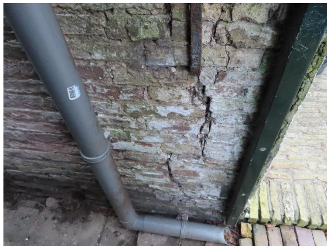
Foto 1; linker gevel bij aansluiting met voorgevel verticaal gescheurd.
