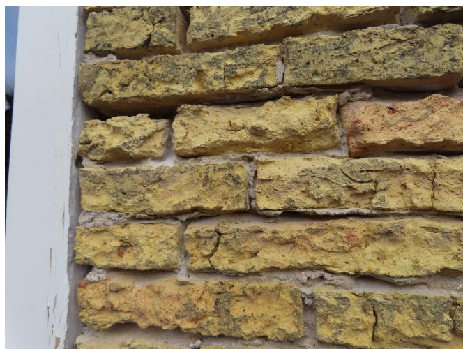
Foto 2; uitgesleten metselwerk en verpulverende stenen.
