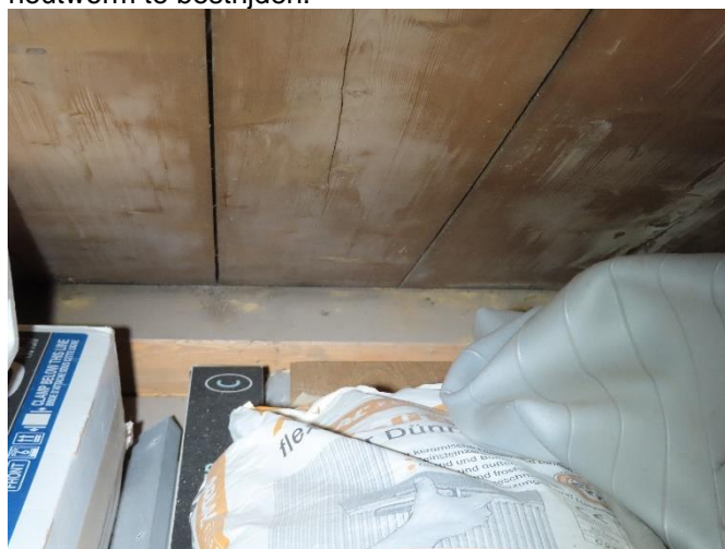
Foto 23; lichtgekleurde sporen boormeeel op vloeringbalk.
