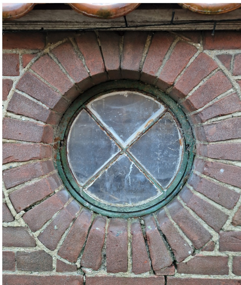
Afb. 41 Het ronde stalen tuimelraam, 2024
