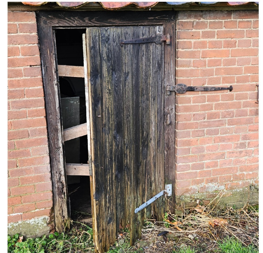
Afb. 30 Foto van een later aangebrachte schapendeur, met een aantal originele gehengen in de oostgevel, vermoedelijk uit de tweede bouwphase, de deur heeft uit twee delen bestaan maar is vervangen, 2024
