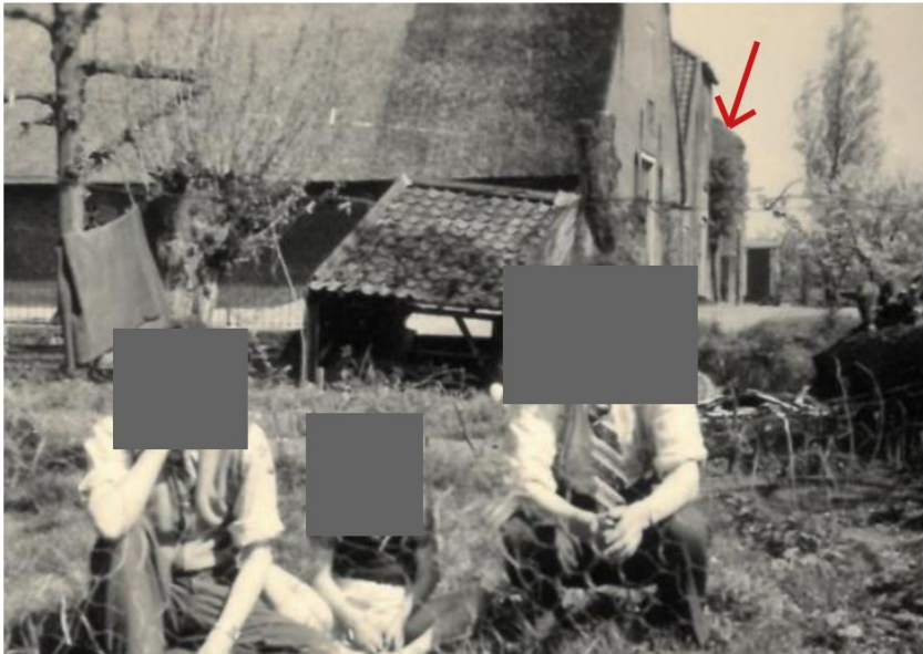
Afb. 22 Foto van her erf met achterin de voormalige schapenstal. Wat zichtbaar is, is dat de rietenkap nog op het westelijk dakvlak aanwezig was, 1960. Bron: Gerard den Hartog
