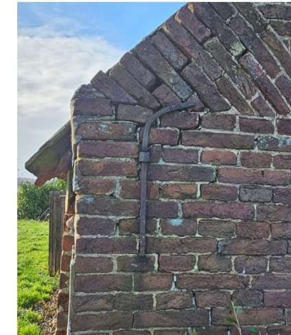
Afb. 25 Gebogen gevelanker in de linkerkant van de kopgevel, 2024
