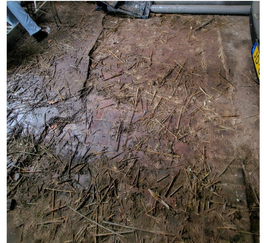
Afb. 55 De klinkervloer achterin de schuur in het travee, 2024
