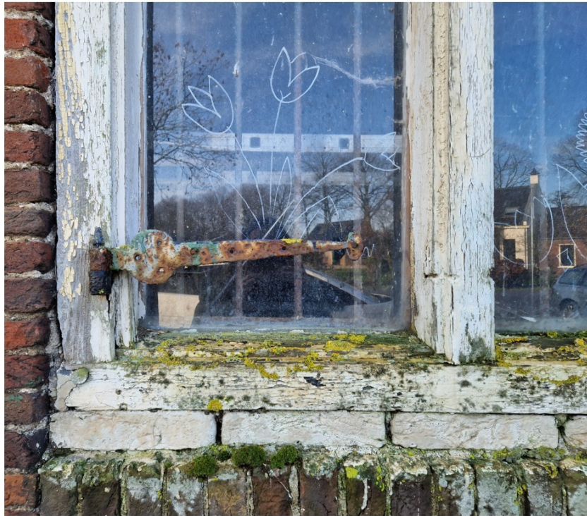
Afb. 20 Foto van het ingemetselde venster op de plek van de voormalige staldeuren, het venster heeft luiken gehad, 2024
