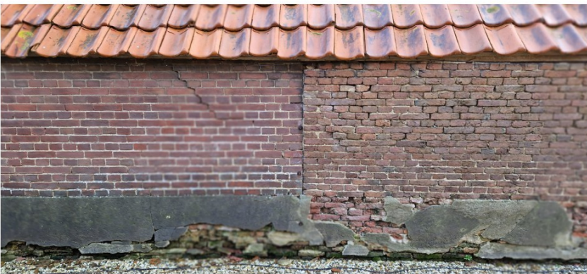
Afb. 10, Links een jonge bakstenen gevel, rechts de oorspronkelijke westgevel met hoekverband, 2023
