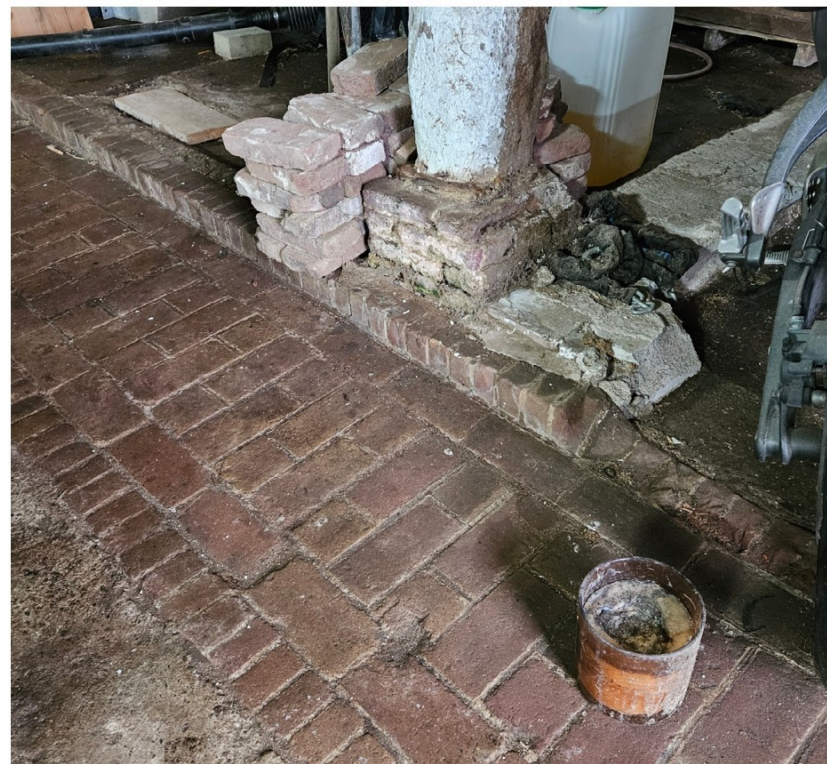
Afb. 54 De voergang tussen de betonnavloeren, met de opgehoogde vloer in de zijbeuk, 2024
