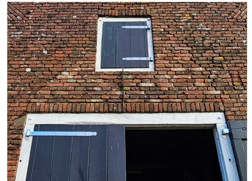
Afb. 37 (5) & (6) Op de plaats waar oorspronkelijk de grupdeur heeft gezeten, zit nu een kozijn, 2024
