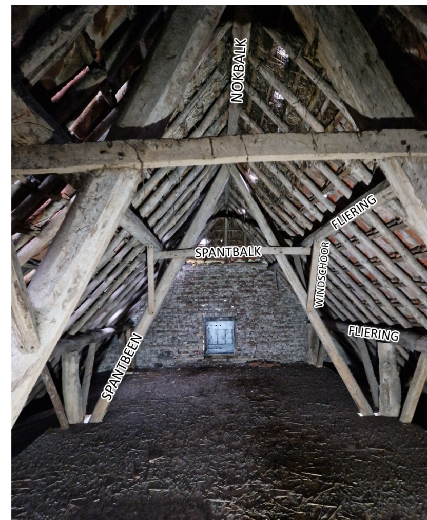
Afb. 47 A-spanten bovenop de ankerbalken met aanduiding van onderdelen, 2024
