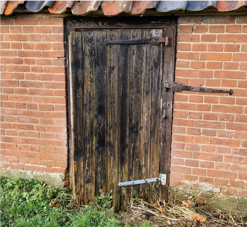
Afb. 19 Foto van een latere schapendeur met een aantal originele gehengen in de oostgevel, vermoedelijk uit de tweede bouwphase, de deur heeft uit twee delen bestaan maar is vervangen, 2024
