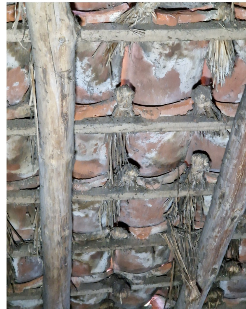
Afb. 51 De strodokken tussen de panlatten en de Oudhollandse pannen, 2024
