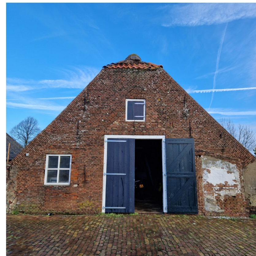
Afb. 8 Foto van de zuidelijke kopgevel, 2024
