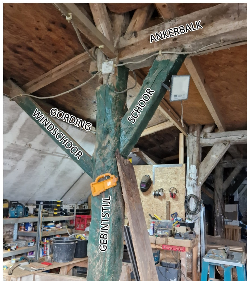
Afb. 45 Foto van het ankerbalkgebint met aanduiding van onderdelen, 2024
