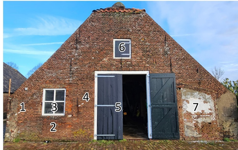
Afb. 32 De zuidelijke kopgevel is opgebouwd uit miskleurig metselwerk en bevat boerenvlechtelingen, met aanduiding van de beschreven onderdelen, 2024
