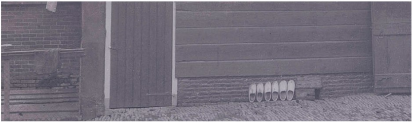
Referentie afb. 17 Dit beeld geeft een indruk hoe de verdwenen beschieting boven de gemetselde plint er mogelijk uit heeft gezien, de foto is genomen van de achtergevel van een boerderij in Oosterwijk, gemeente Vijfheerenlanden, bron: RCE beeldbank, fotograaf K. Uilkema (1924)
