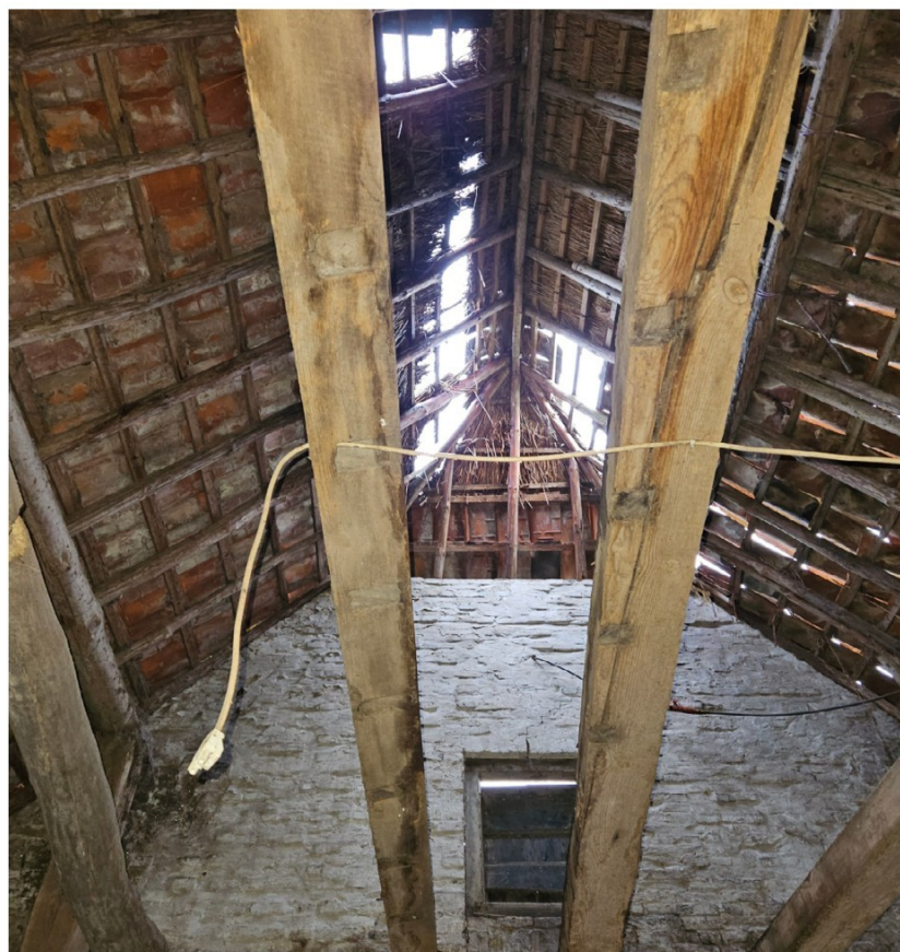
Afb. 50 Foto van de tasliggers, hergebruikte onderdelen van wieken, 2024
