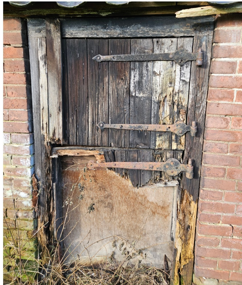
Afb. 28 Foto van de oorspronkelijke schapendeur, met originele gehengen in de oostgevel, vermoedelijk afkomstig uit de eerste bouwphase van het pand, 2024
