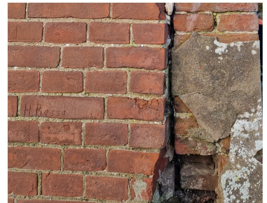
Afb. 31 Middenlinks zijn ingekerfde initialen en naam van 'H. Rossa' te zien, rechts de koude aansluiting op het 19e eeuwse metselwerk, 2024
