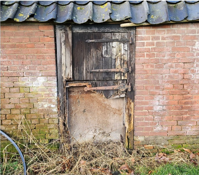
Afb. 18 Foto van de oorspronkelijke schapendeur met originele gehengen in de oostgevel, vermoedelijk afkomstig uit de eerste bouwphase van het pand, 2024
