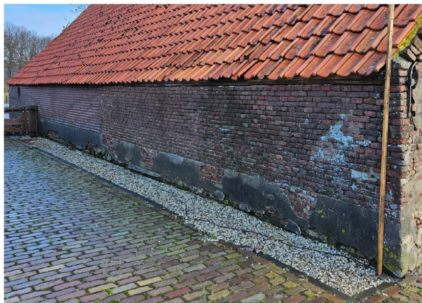
Afb. 40 De westelijke langsgevel met links het 20e eeuwse metselwerk en rechts het metselwerk uit de eerste bouwphase, 2024
