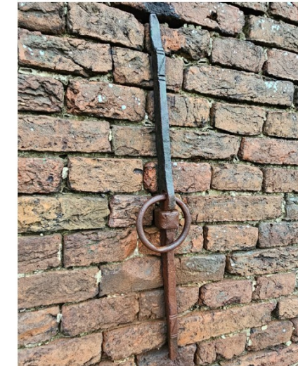
Afb. 36 (4) Anker met gesmeden ring boven de strop, 2024
