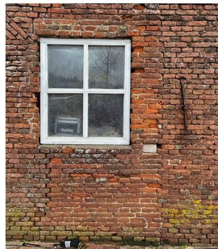
Afb. 35 (2) & (3) Op de plaats waar oorspronkelijk de grupdeur heeft gezeten, zit nu een kozijn, 2024
