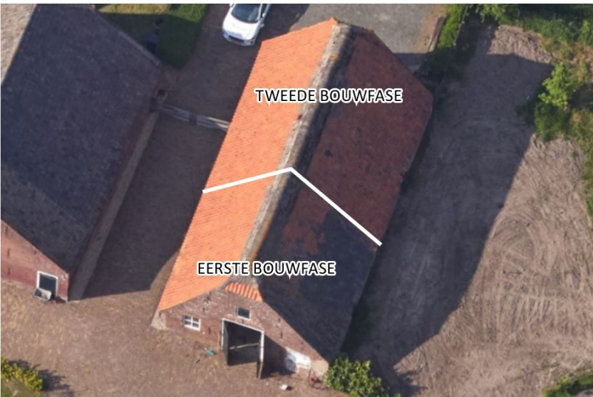
Afb. 9 Luchtfoto van de voormalige schapenstal en wagenshuur, het oorspronkelijke deel en de uitbreiding, Bron: Vision 10 (2023)
