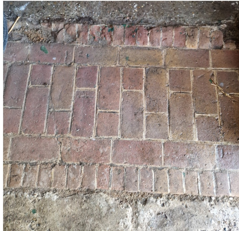
Afb. 53 De voergang tussen de betonnavloeren, 2024
