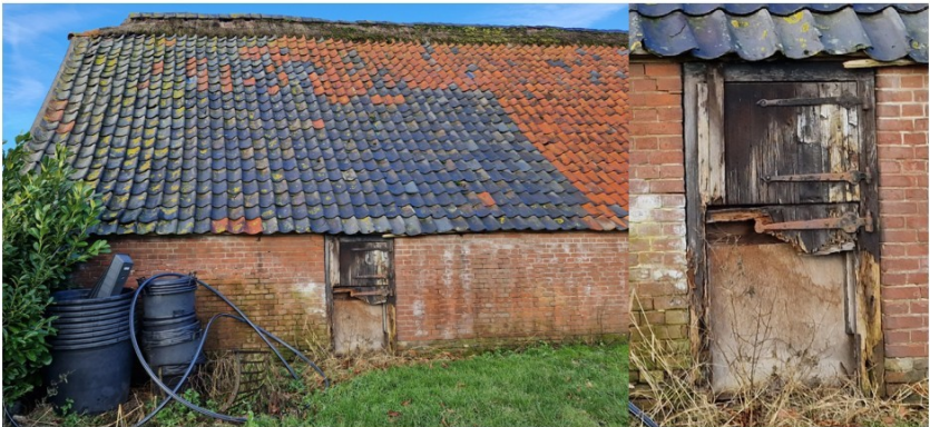
Afb. 11 Oostgevel, met op het linker dakvlak gesmoorde pannen en in de gevel een opnieuw ingemetselde tweedelige weide deur voor de schapen, 2023
