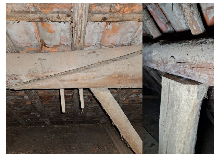
Afb. 48 De naaldhouten flieger met schuine lasverbinding en toognagels, 2024
