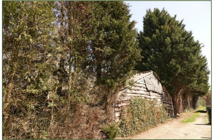
Fig. 2.10 Achterzijde houten schuur (bron: [redacted])
