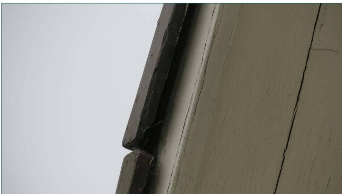
Figuur 3.1 Kierende dakpannen aan de kopgevels van Boulevard de Wielingen 16 te Cadzand-Bad.
