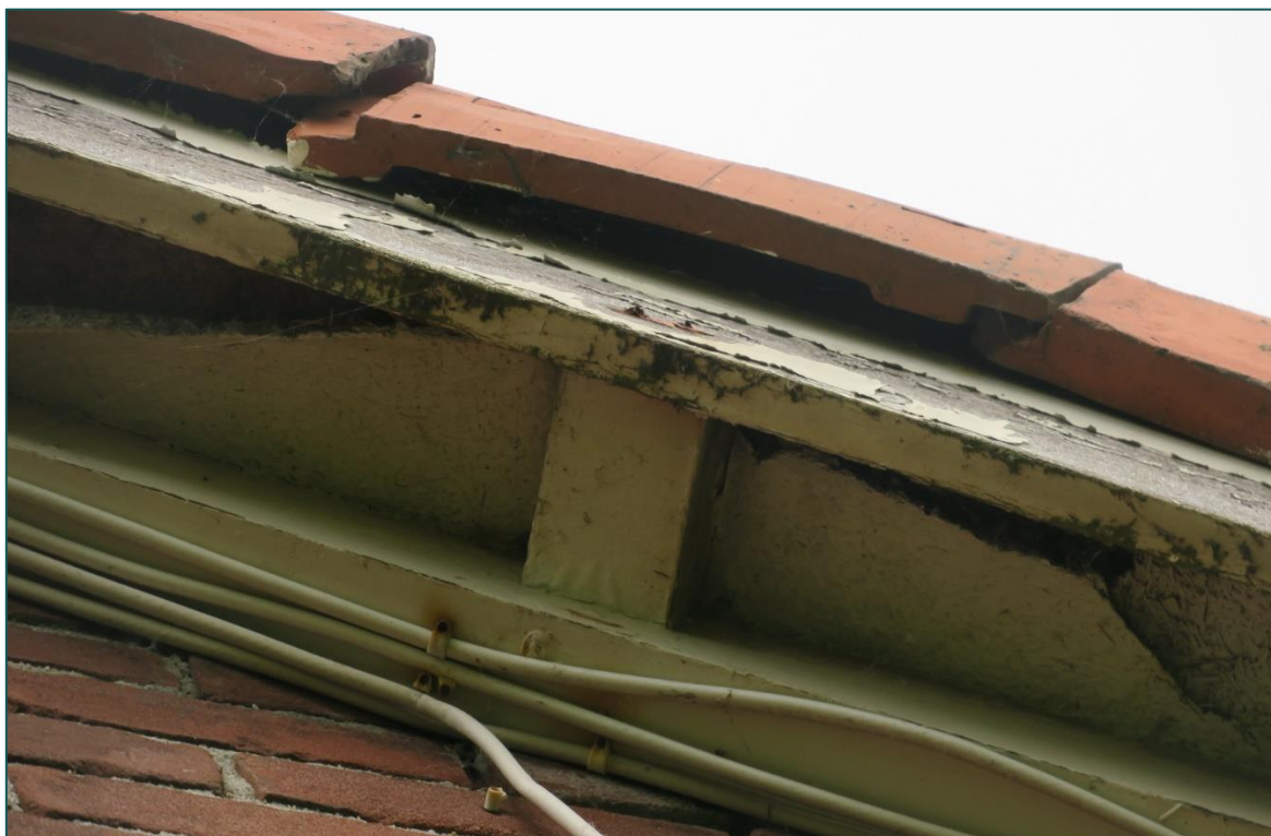
Figuur 3.3 Kierende dakpannen aan de kopgevels en ventilatiegaten aan de Boulevard de Wielingen 24 te Cadzand-Bad.
