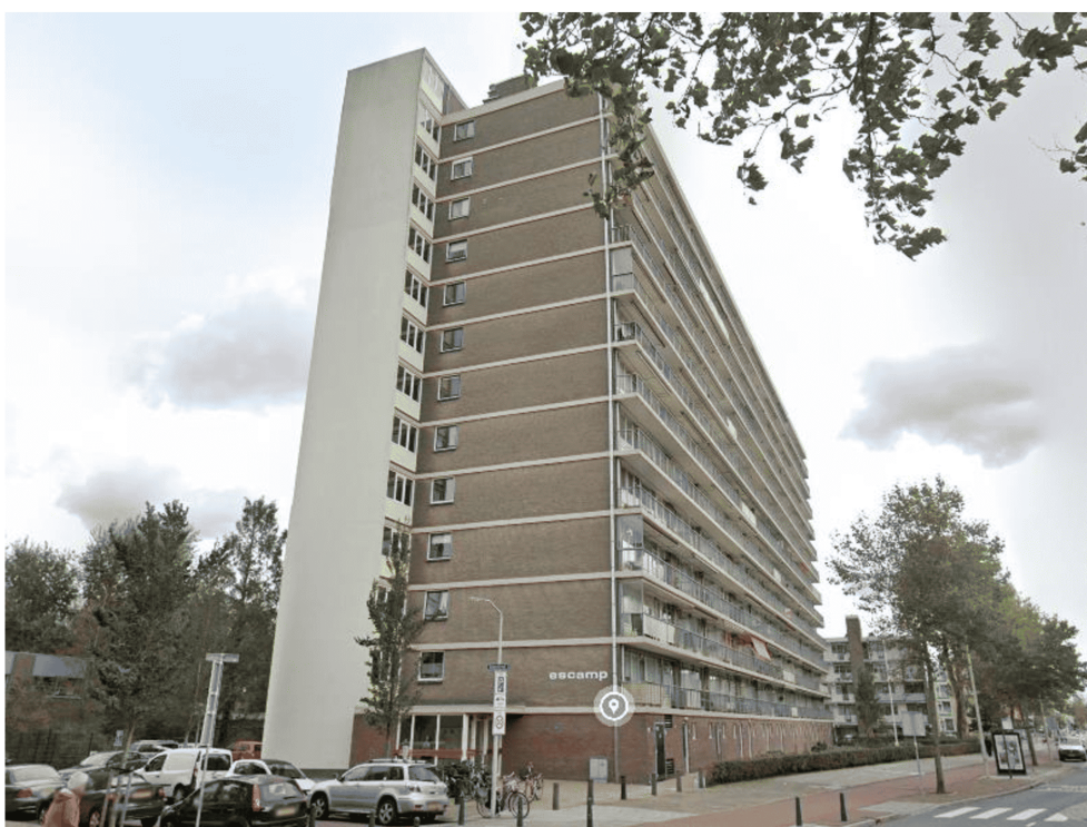
Op zowel de noord- als de zuidgevel van dit appartementencomplex uit 1965 aan de Leyweg 90-150 werden in totaal 11 zwermers waargenomen. Foto: Google Streetview.
