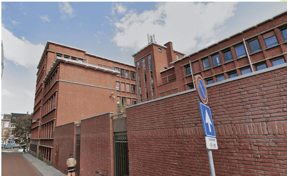
Op deze zuidgevel van een jaren 50-complex aan de Torenstraat werden 2 zwermende gewone dwergvleermuizen waargenomen. Foto: Google Streetview.
