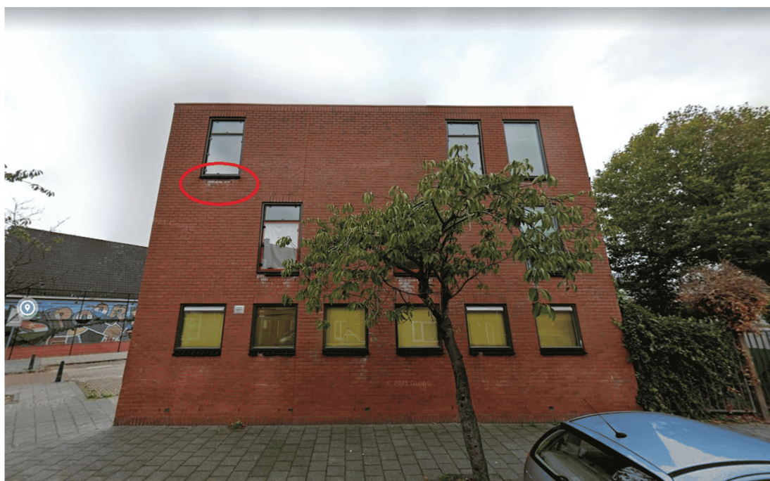
Jonathanstraat. Zomerverblijfplaats in een open stootvoeg (rode cirkel). Bron: Google Street View.
