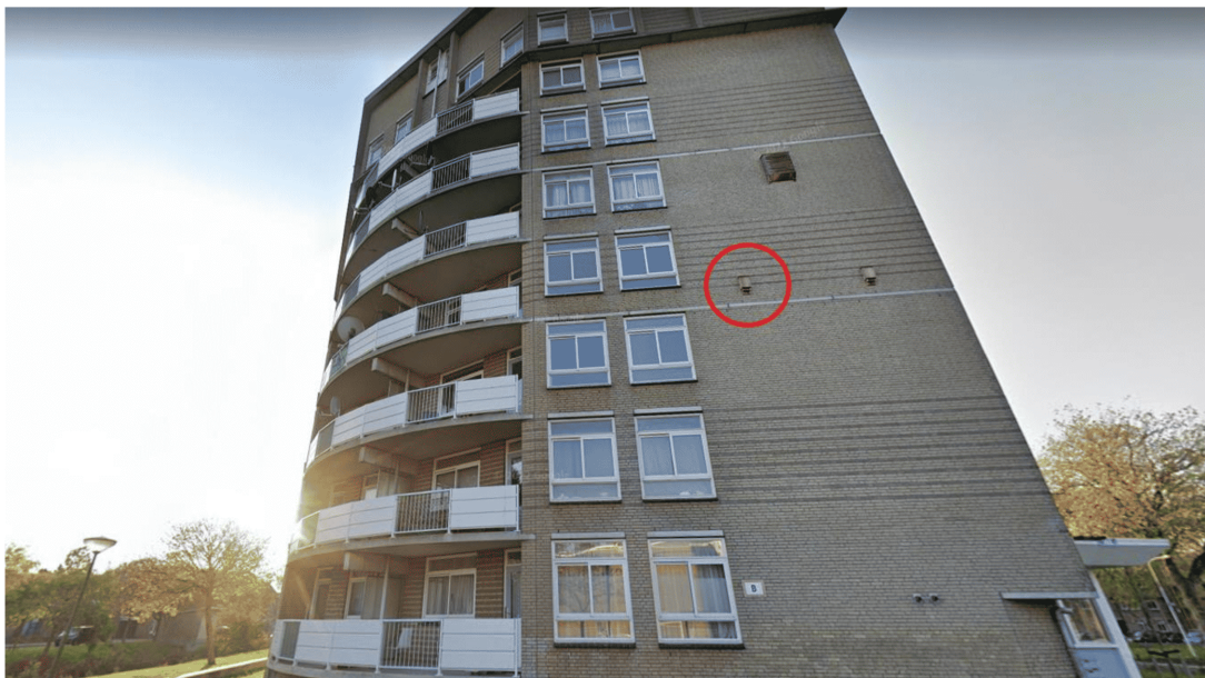
Stuwstraat. Twee gewone dwergvleermuizen aanwezig in de linker mitigatiekast (rode cirkel). Bron: Google Street View.
