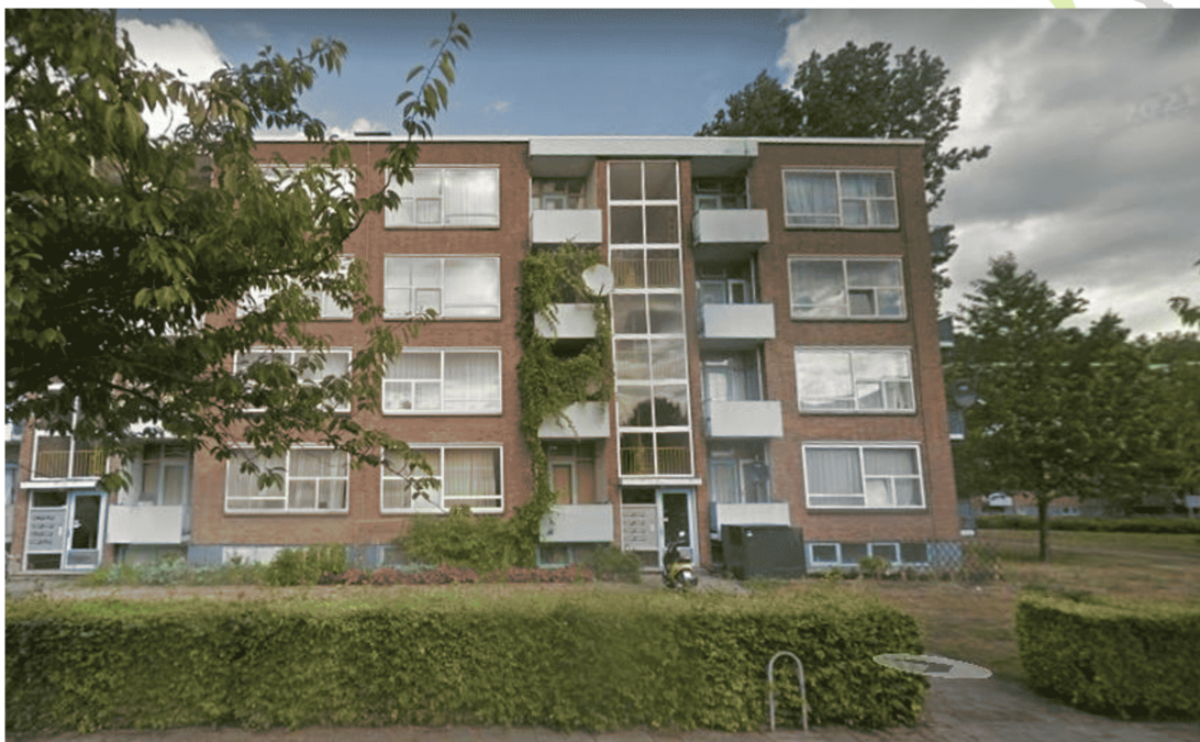
Kraamverblijfplaats Hoogveen 81, verblijfplaats in de spouwmuur. Foto: Google Street View.
