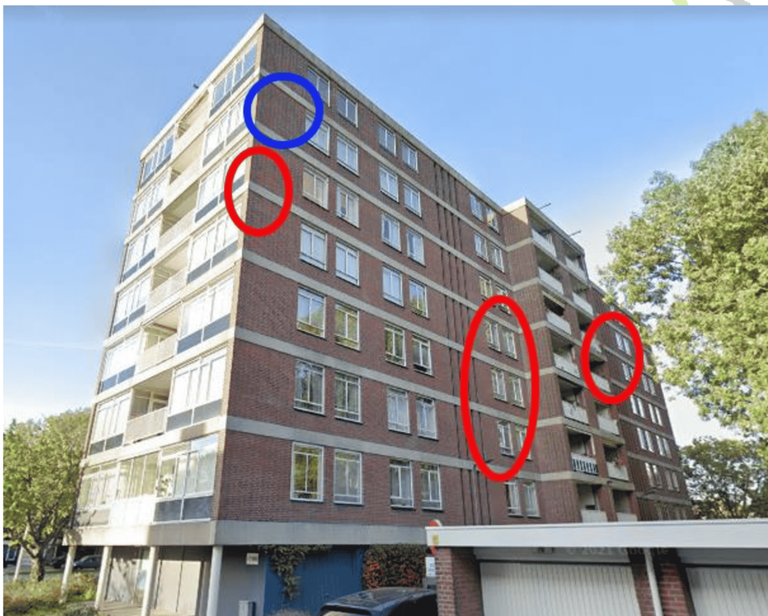
Kraamverblijfplaatsen gewone dwergveermuis aan de Kornalijnhorst 2 – 36 (rood omkaderd de uitvliegplekken) en de zomerverblijfplaats van rosse vleermuis (blauw gemarkeerd). Foto: Google Street View.
