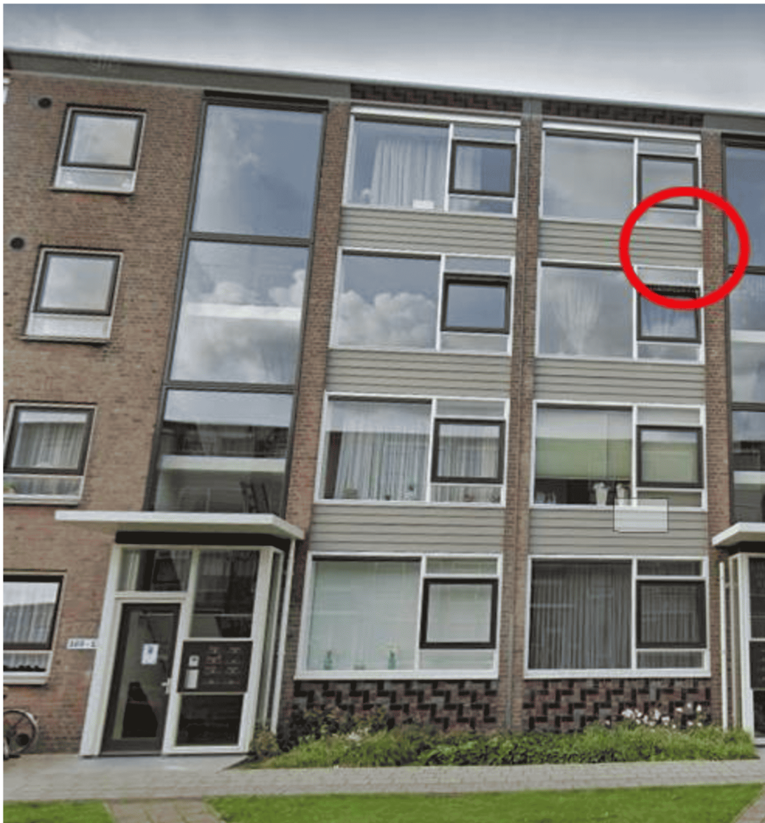
Nettelhorststraat 8-101. Als gevolg van renovatie is deze verblijfplaats, vermoedelijk gevestigd achter een borstwering, verloren gegaan. Bron foto: Google Street View.
