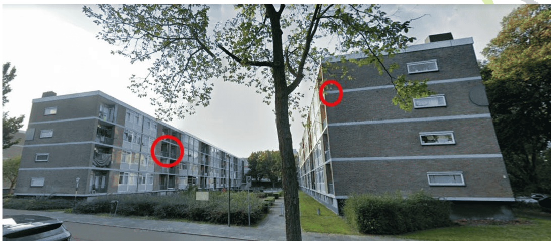
Kraamverblijfplaatsen Rechts de Steenhouwersgaarde 155, verblijfplaats in de spouw van de zijgevel. Links de Barbiersgaarde waar de kraamverblijfplaats in de spouw op de derde etage gelegen is. Foto: Google Street View.
