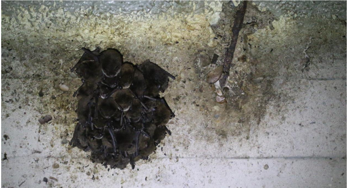
Een kolonie watervleermuizen werd gevonden onder een brug nabij het centrum
