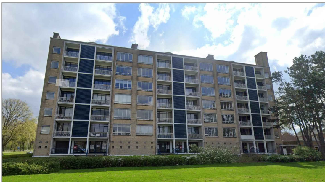
Jacob Mulderweg 103-105, deelgebied 74. De andere verblijfplaats aan de Jacob Mulderweg bevindt zich in een vergelijkbaar gebouw. Bron: Google Maps
