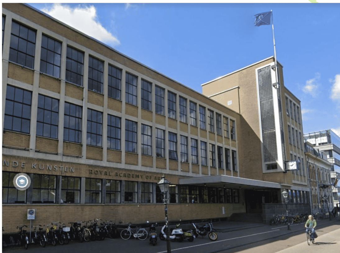
Figuur 46: Nabij het hogere deel van dit pand aan de Prinsessegracht is een winterverblijfplaats aangetroffen.
