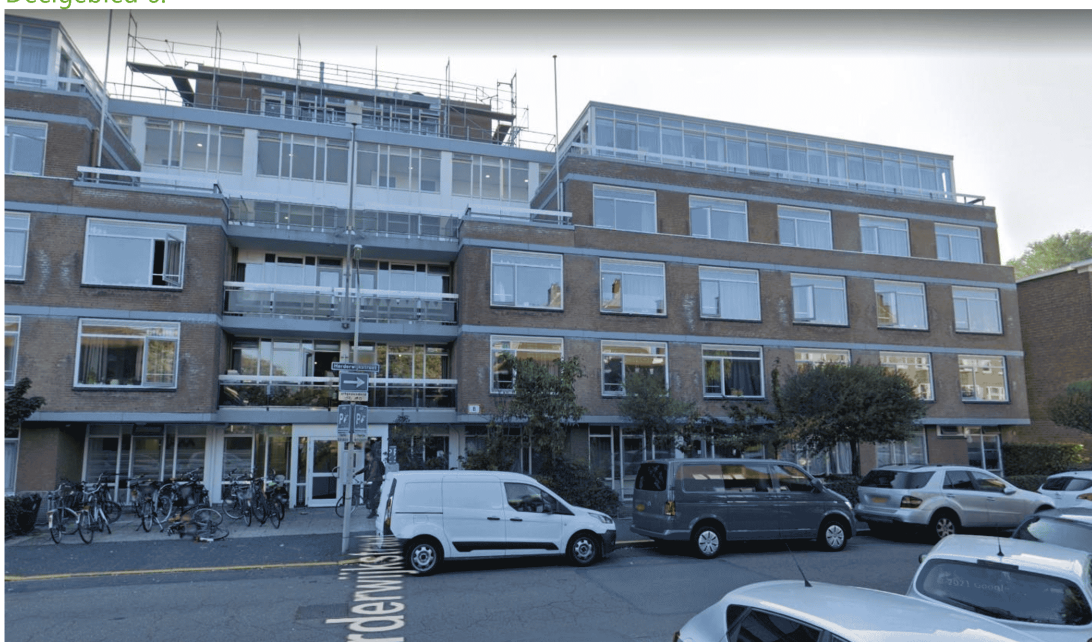
Figuur 13: Het appartementencomplex langs de Harderwijkstraat.
