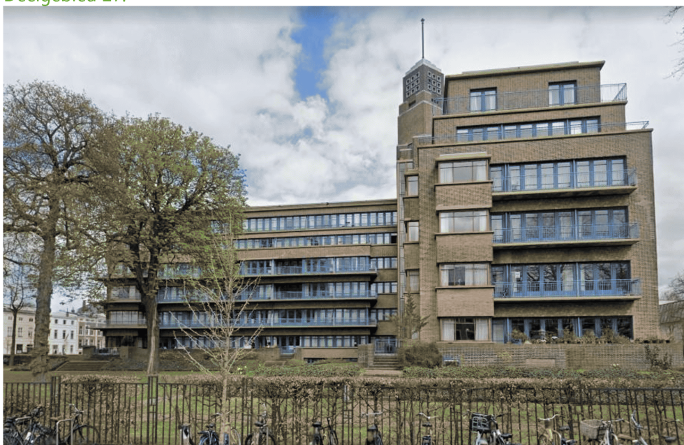
Figuur 37: Het appartementencomplex aan de Zeeweg.
