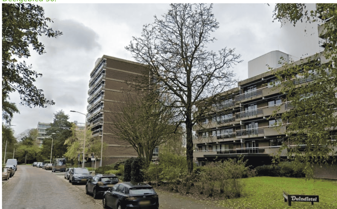
Figuur 47: In 3 complexen langs de Else Mauhsloot zijn winterverblijfplaatsen aangetroffen.
