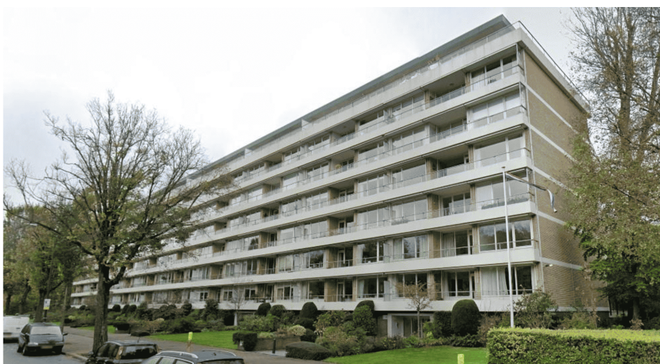
Figuur 52: Een van de identieke flats aan de Ruychrocklaan.
