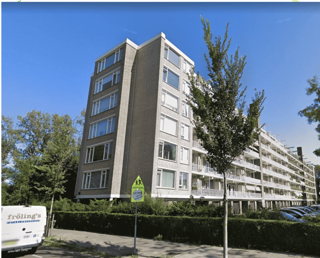
Figuur 24: Aan de kopgevel van deze flat aan de Cornelie van Zantenstraat is een winterverblijfplaats aangetroffen.
