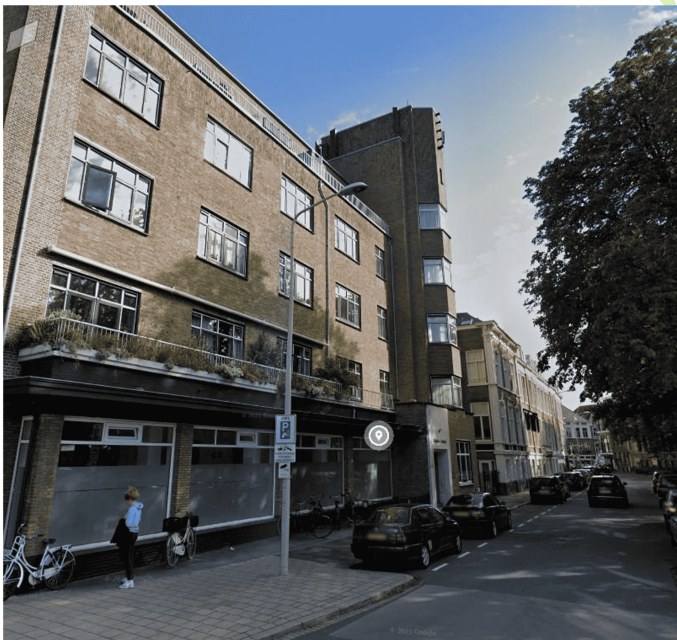
Figuur 36: Langs de Anna Paulownastraat zijn 2 winterverblijfplaatsen aangetroffen. Een bij hoger gelegen deel (nr. 117) en bij het naastgelegen lagere deel (nr. 115).
