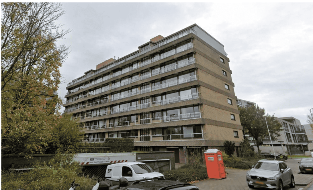
Figuur 9: Een van de vele flats/complexen met bakstenen gevels en betonnen afscheidingen tussen de etagevloeren.
