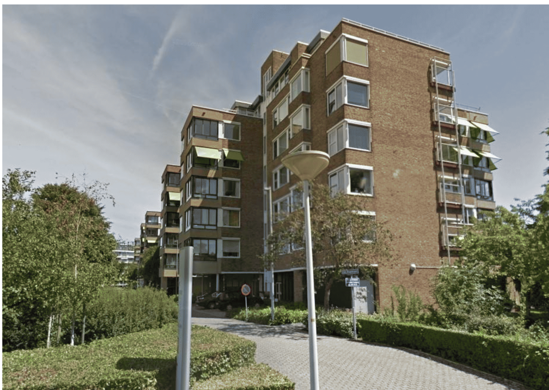
Figuur 49: Langs de gevels van dit grote complex aan de Jan Muschlaan zijn 4 winterverblijfplaatsen aangetroffen.
