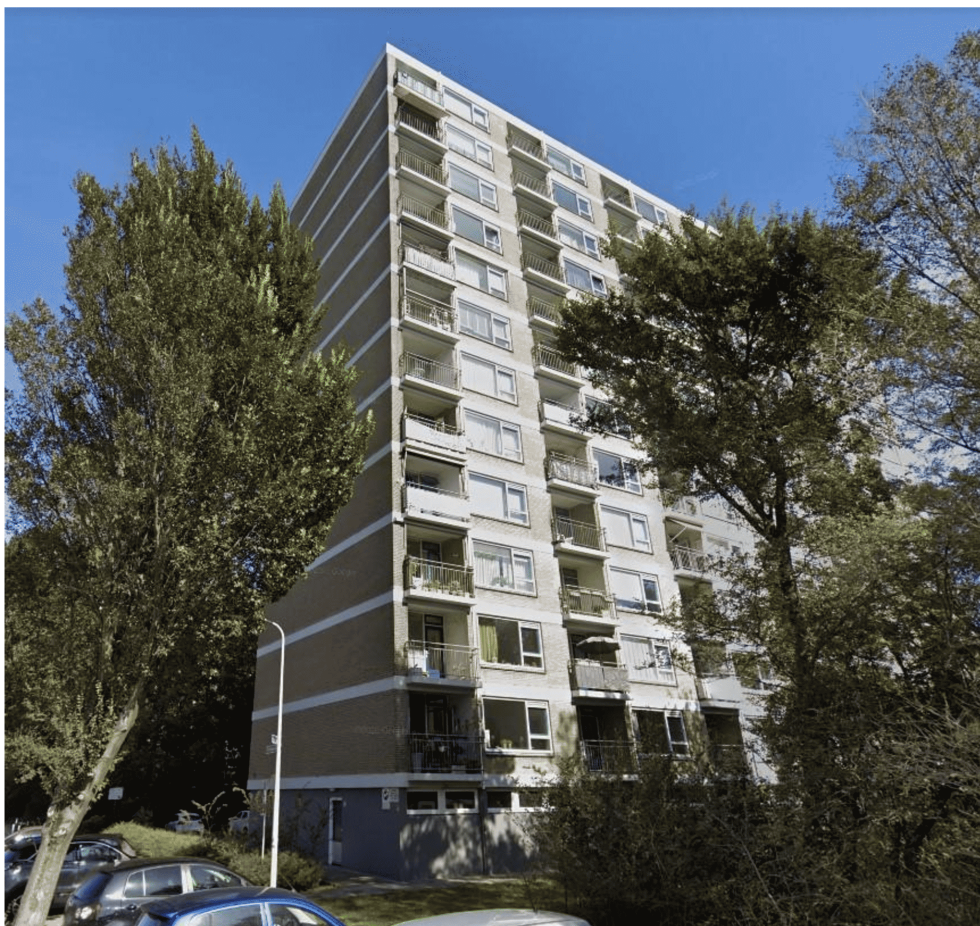
Figuur 29: Een van 2 identieke flats aan de Eicalaan waar winterverblijfplaatsen zijn aangetroffen.
