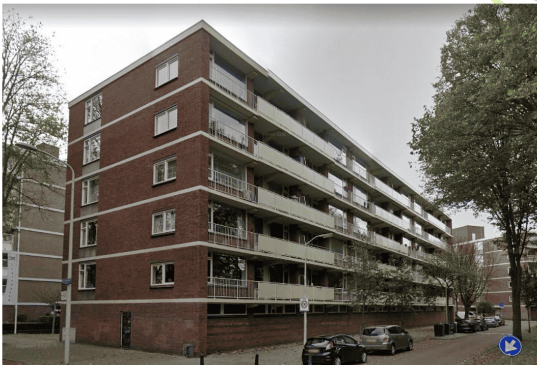
Figuur 8: Een van de vele flats/complexen met bakstenen gevels en betonnen afscheidingen tussen de etagevloeren.
