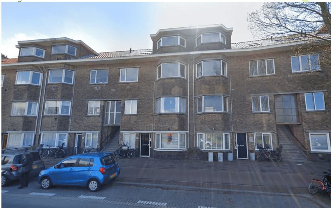
Figuur 34: Zwolsestraat 403, waar een winterverblijfplaats is aangetroffen.
