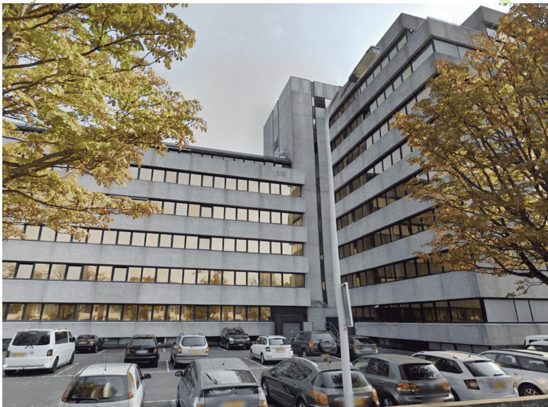
Figuur 53: Het kantoorgebouw aan de Laan van Nieuw Oost-Indië.
