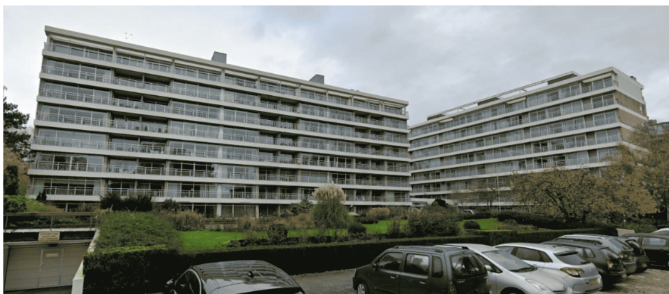
Figuur 50: In dit deelgebied zijn 8 in identieke grote flats in totaal 15 winterverblijfplaatsen aangetroffen. Deze flats liggen aan de Cees Laseurlaan, Jan Muschlaan en Ruychrocklaan. Op de foto 2 complexen aan de Cees Laseurlaan waar 4 winterverblijfplaatsen zijn aangetroffen.
