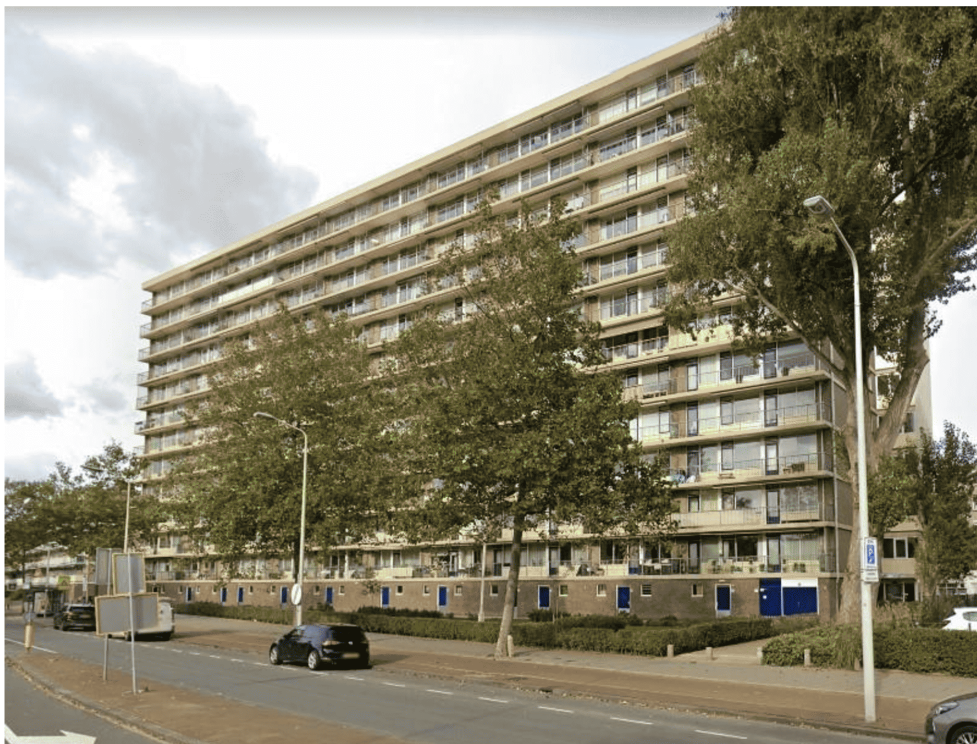
Figuur 17: De flat gelegen langs de Leyweg. Ook hier werden 2 winterverblijfplaatsen aangetroffen.
