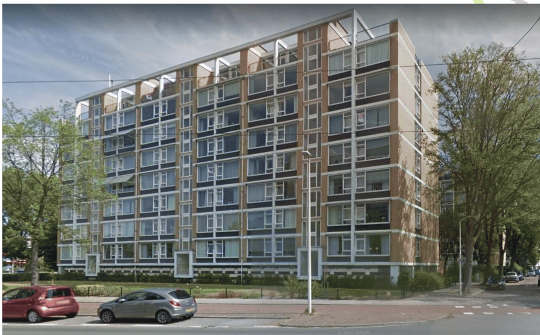
Figuur 22: Langs de gevels van 3 identieke flats aan de Louis Davidsstraat zijn zwermende dieren aangetroffen.
