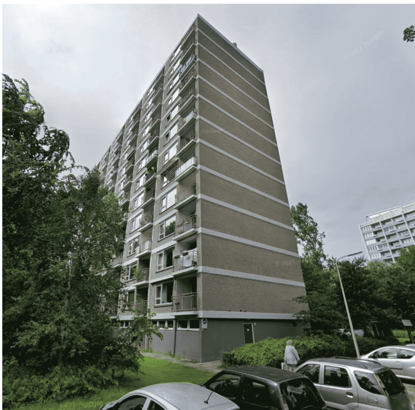
Figuur 30: De zuidelijke flat aan de Heitrooplaan 150-220A.
