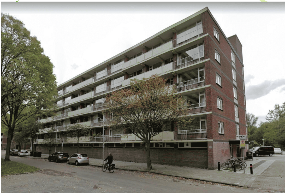
Figuur 14: Een van de 2 type flats langs de Nieuwendamlaan. In 3 van deze flats zijn winterverblijfplaatsen aangetroffen.
