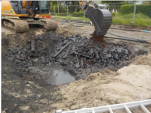
Ontgraven mobiele verontreiniging
