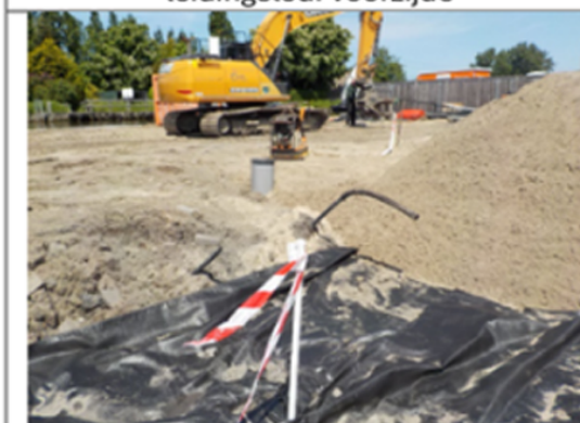
Controlepeilbuis 1 in leidingsleuf ten zuiden van ontgraving mobiele verontreiniging
