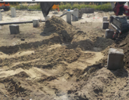
Ontgraven toplaag en onderlaag funderingsbalken na heien
