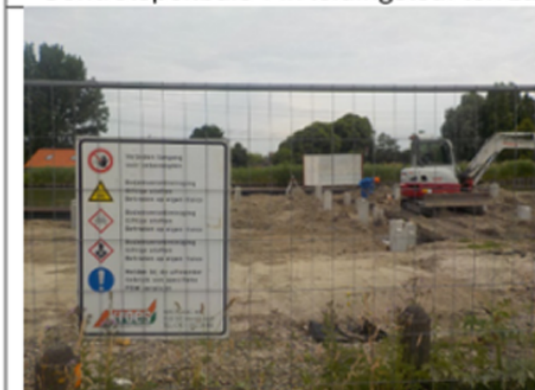
Ontgraven toplaag en onderlaag funderingsbalken na heien
