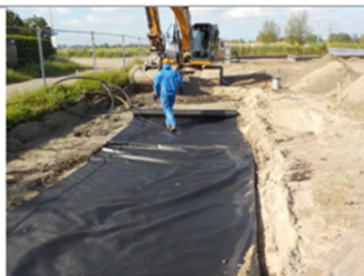
Aanbrengen gronddoek in leidingsleuf voorzijde
