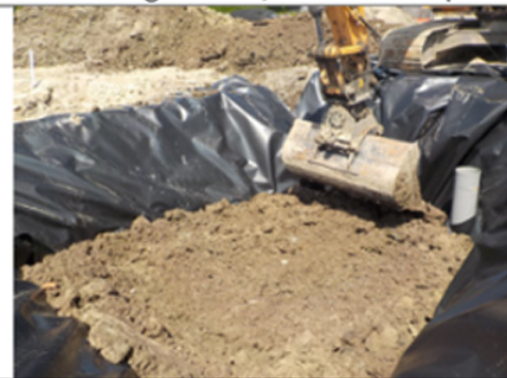
Aanvullend ontgraving met klei
