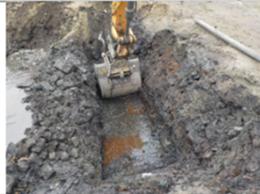
Ontgraven mobiele verontreiniging
