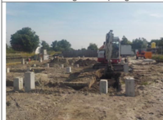
Ontgraven toplaag en onderlaag funderingsbalken na heien
