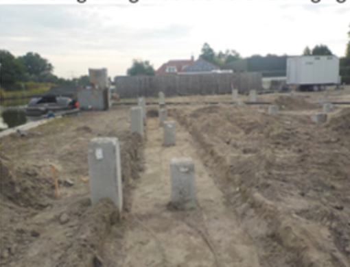
Ontgraven toplaag en onderlaag funderingsbalken na heien
