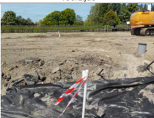
Controlepeilbuis 1 in leidingsleuf ten zuiden van ontgraving mobiele verontreiniging
