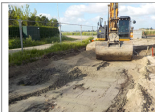
Ontgraven toplaag en onderlaag leidingsleuf voorzijde
