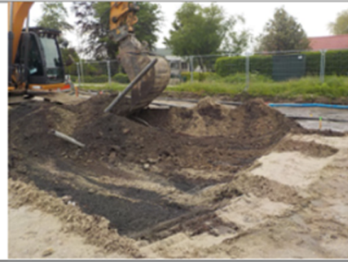
Verwijderen toplaag en onderlaag
