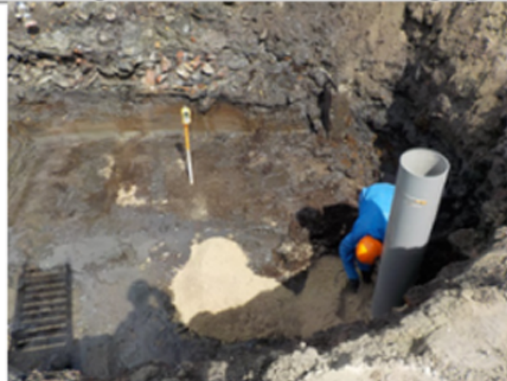
Aanbrengen drain, zand en drainput
