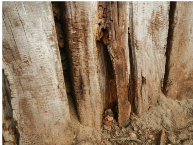
Figuur 44: Sectie 11, aantasting op maaiveld niveau
