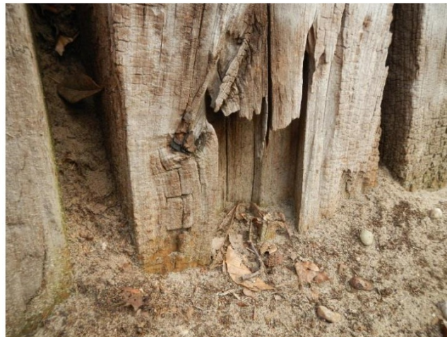
Figuur 38: Sectie 9, aantasting op maaiveld niveau
