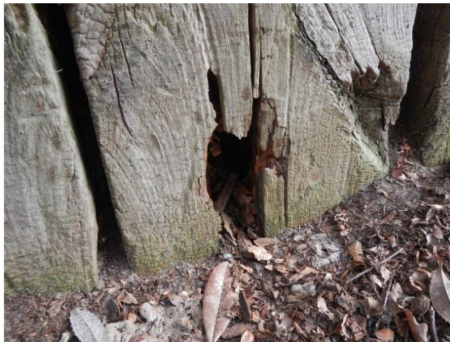
Figuur 20: Sectie 3, aantasting maaiveld niveau
