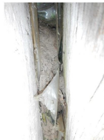
Figuur 33: Sectie 7, beschadigd plastic tussen de verticale bielzen
