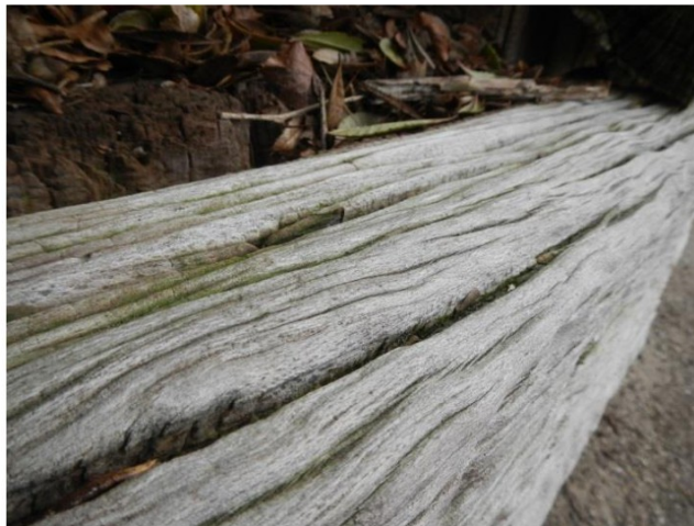
Figuur 35: Sectie 8, veroudering hout gording
