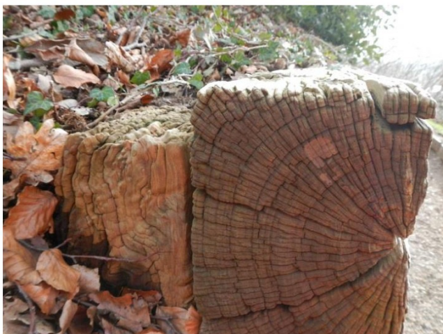
Figuur 25: Sectie 5, veroudering kop van de gording
