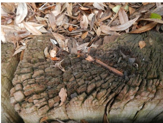
Figuur 39: Sectie 9, aantasting kops hout verticaal (algemeen)
