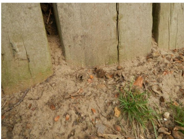
Figuur 58: Sectie 16, enige zand uitspoeling zichtbaar
