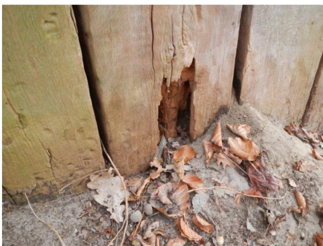
Figuur 13: Sectie 1, aantasting op maaiveld niveau
