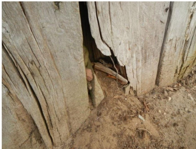
Figuur 47: Sectie 12, aantasting op maaiveld niveau
