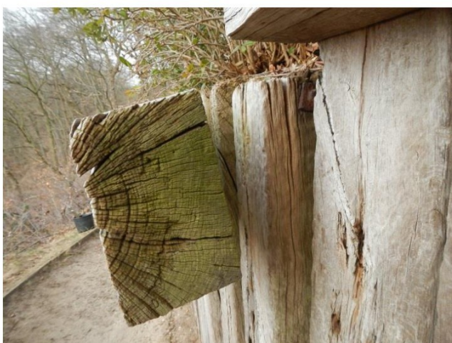
Figuur 42: Sectie 10, scheefstand vertikalen en gording
