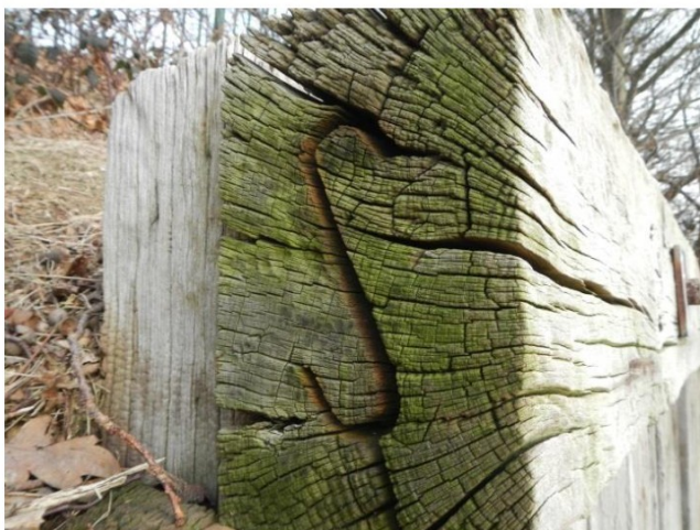
Figuur 48: Sectie 12, veroudering van kops hout
