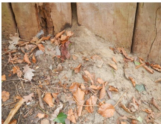
Figuur 14: Sectie 1, uitspoeling op maaiveld niveau
