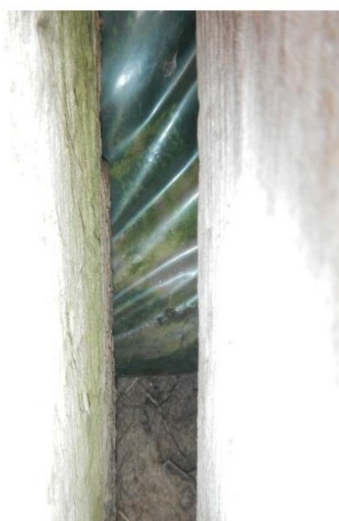
Figuur 36: Sectie 8, plastic tussen de verticale balken
