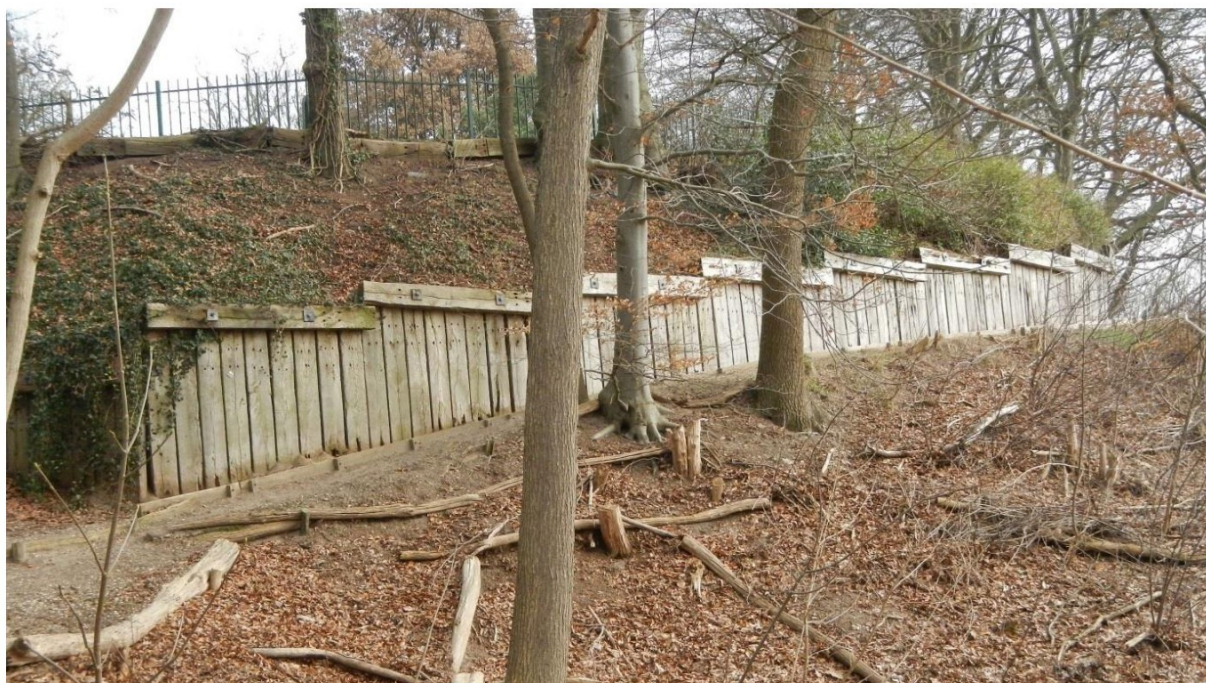
Figuur 1: Aanzicht van (een deel van) de bielzenwand
