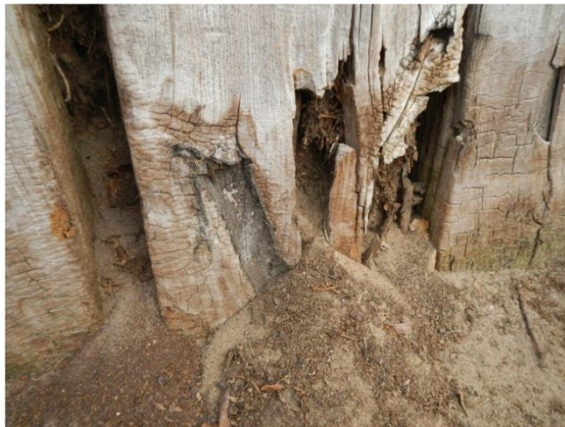
Figuur 41: Sectie 10, aantasting op maaiveld niveau
