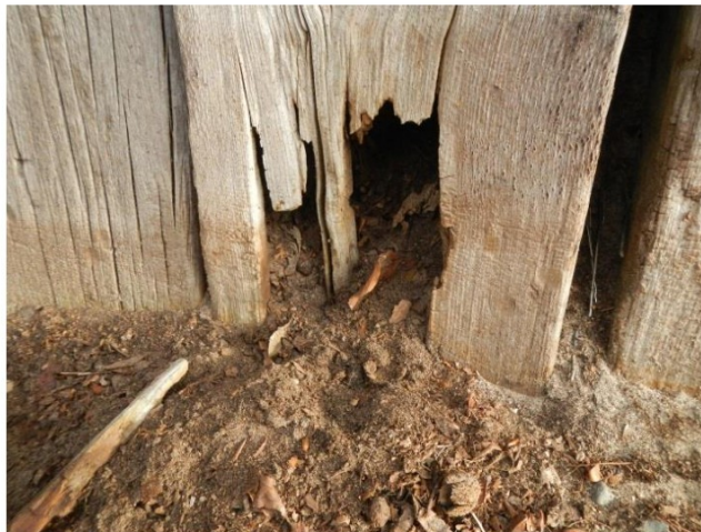
Figuur 24: Sectie 5, aantasting op maaiveld niveau
