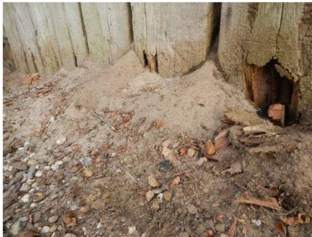
Figuur 16: Sectie 2, uitspoeling maaiveld niveau
