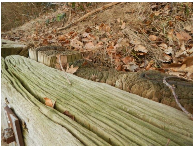
Figuur 51: Sectie 13, veroudering van de gording
