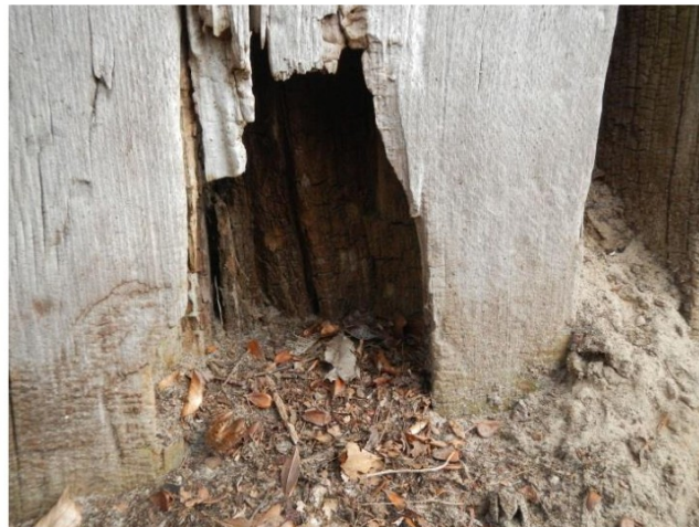
Figuur 27: Sectie 6, aantasting op maaiveld niveau
