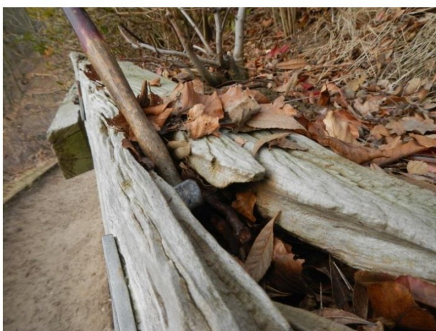
Figuur 45: Sectie 11, gording aangetast bij het anker.
