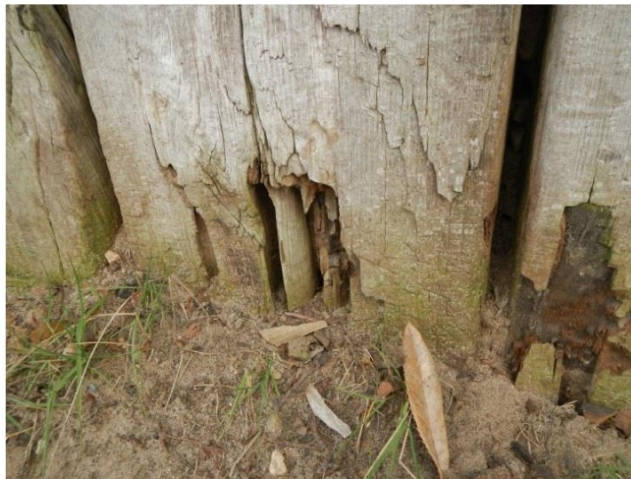
Figuur 50: Sectie 13, aantasting op maaiveld niveau
