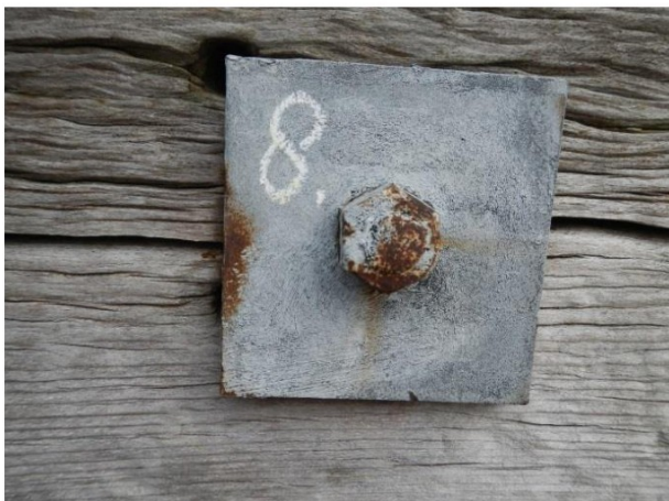
Figuur 5: Verankering, volgplaat en moer (algemeen)
