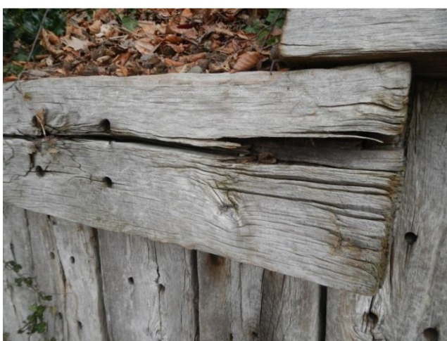
Figuur 28: Sectie 6, veroudering kop van de gording
