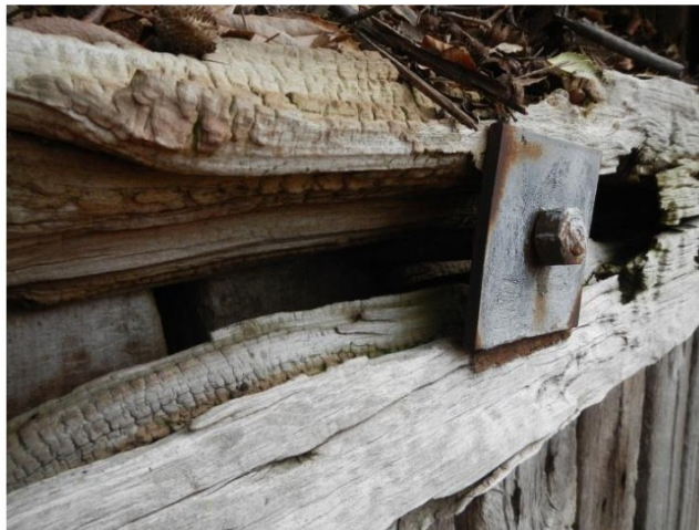
Figuur 31: Sectie 7, aantasting gording
