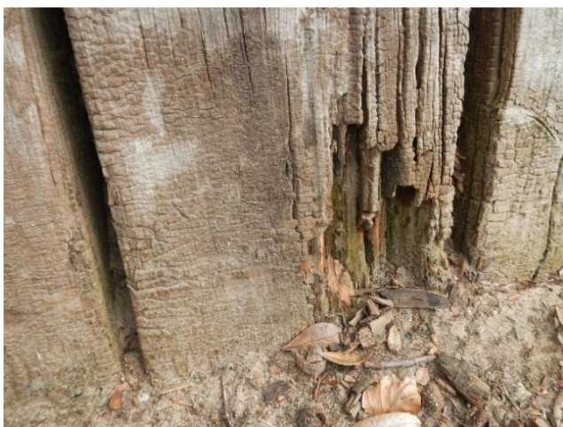
Figuur 32: Sectie 7, aantasting op maaiveld niveau
