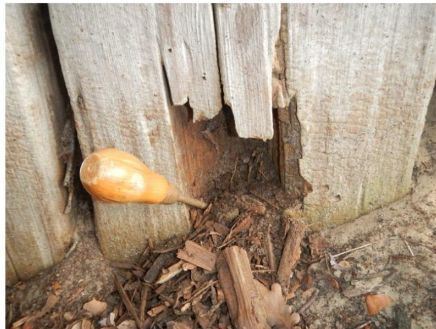
Figuur 22: Sectie 4, aantasting op maaiveld niveau
