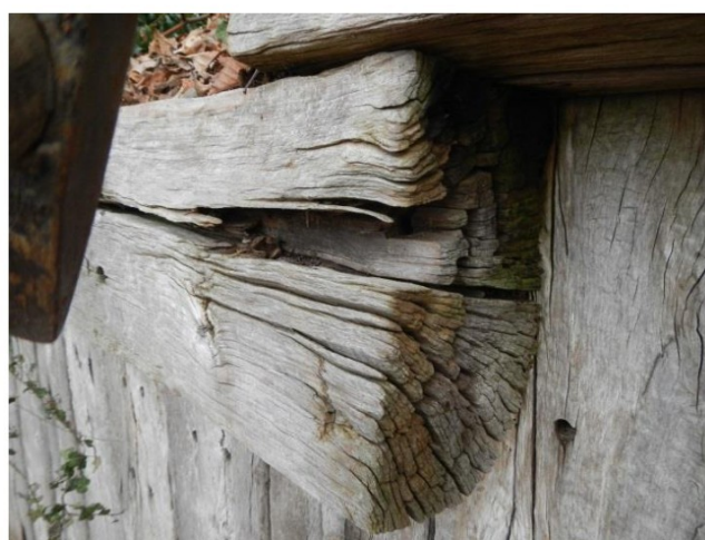
Figuur 29: Sectie 6, veroudering kop van de gording
