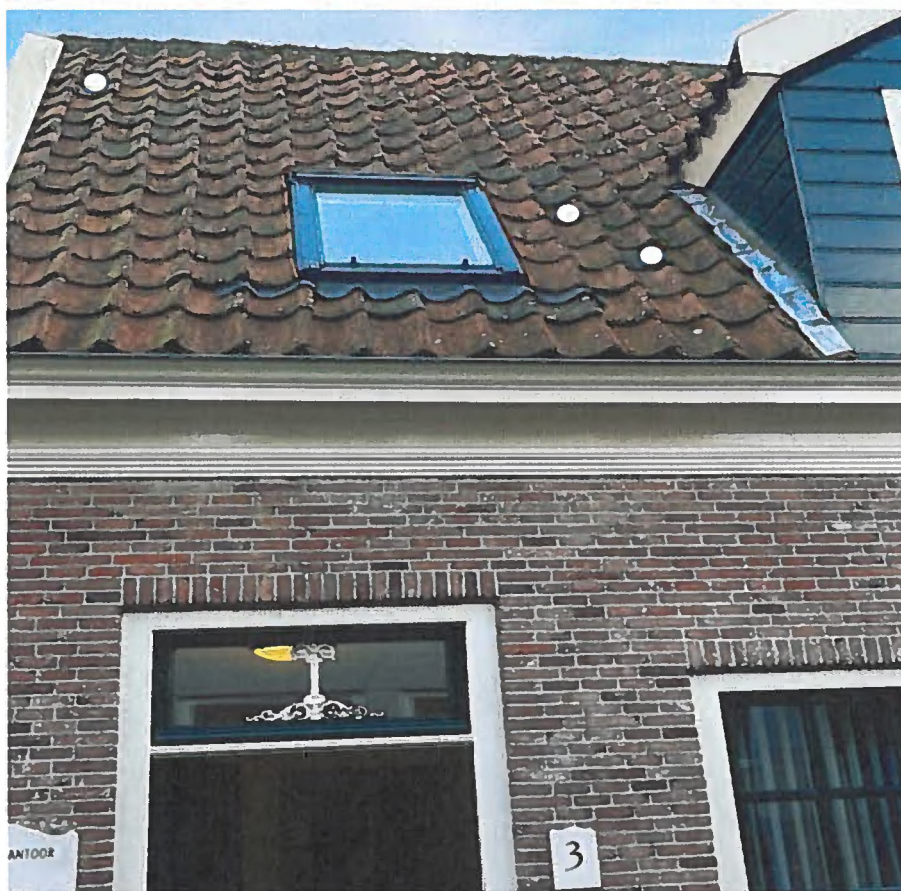
Figuur 3. Weergave van de locaties van de gierzwaluwdakpannen op het noordwestelijk dakvlak van Niesenoort 3.
