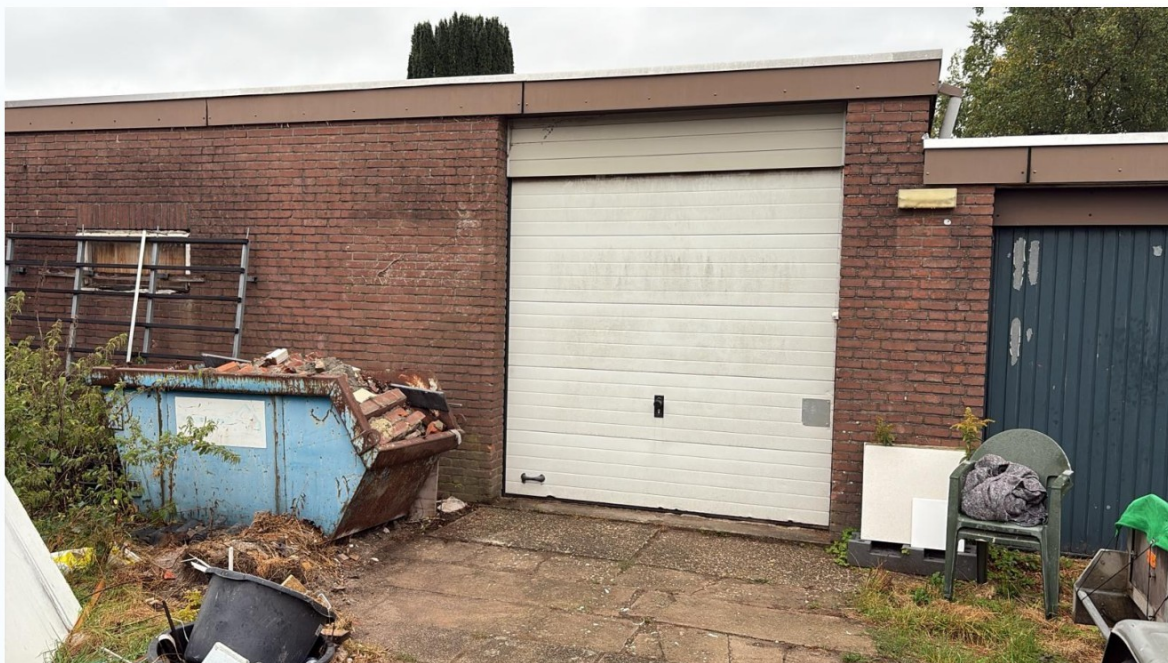
Figuur 6. Gevel van de laagbouw aan de zijde van de Massenweg zonder open stootvoegen.
