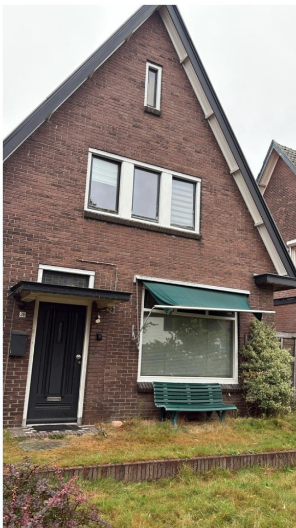
Figuur 7. Voorgevel van woonhuis nr. 28 (links) en zijgevel van nr. 26 (rechts), beiden zonder open stootvoegen.
