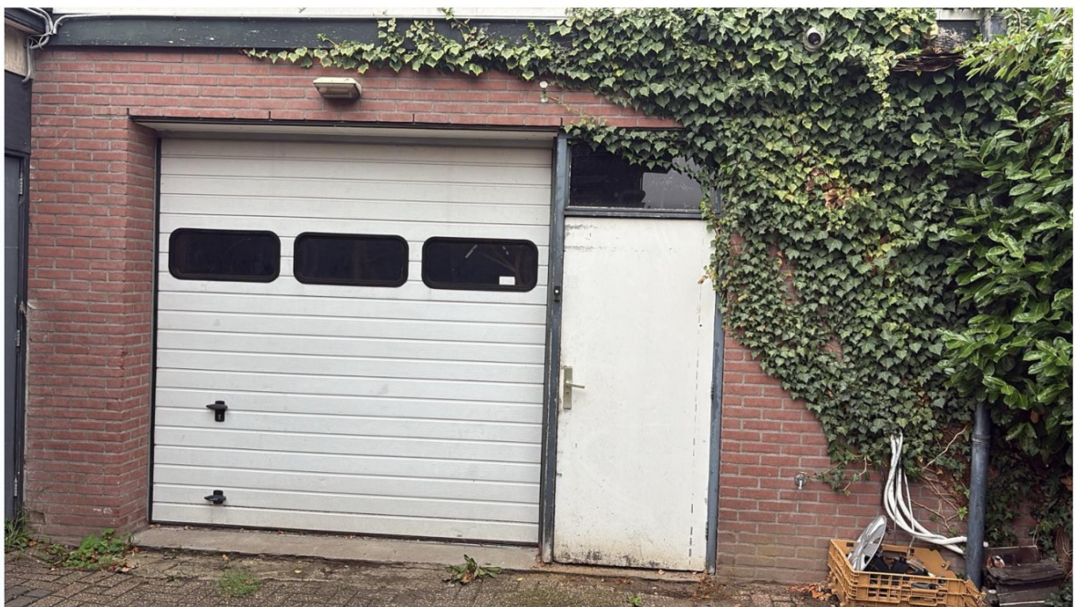
Figuur 1. Open stootvoegen in gevel (voormalig) installatiebedrijf. De enige gevel met een spouwruimte.
