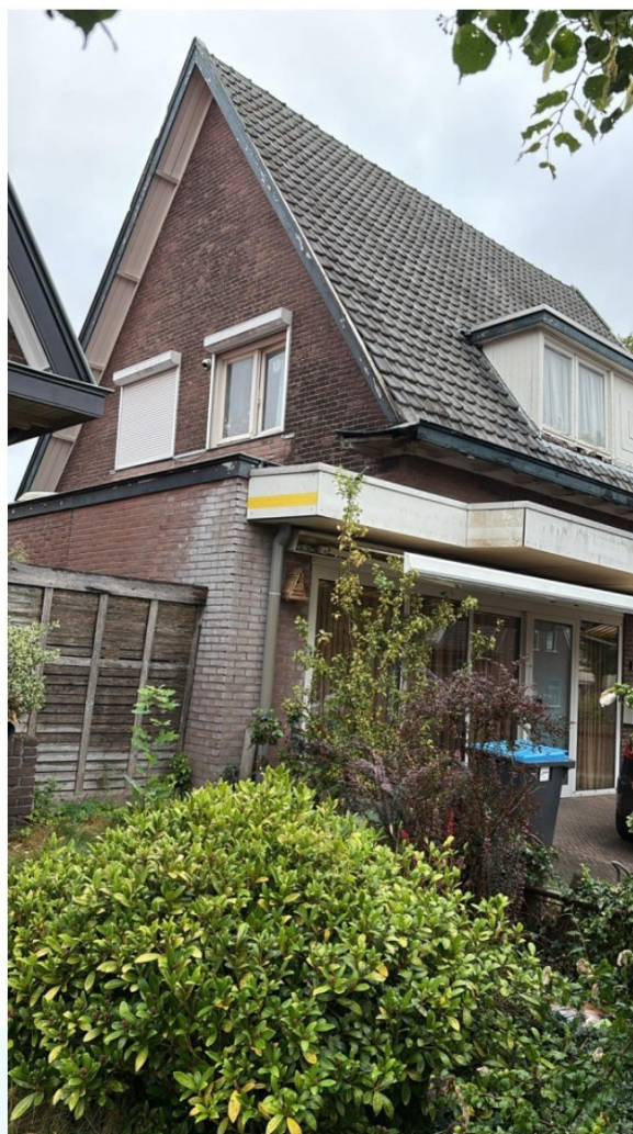
Figuur 7. Voorgevel van woonhuis nr. 28 (links) en zijgevel van nr. 26 (rechts), beiden zonder open stootvoegen.
