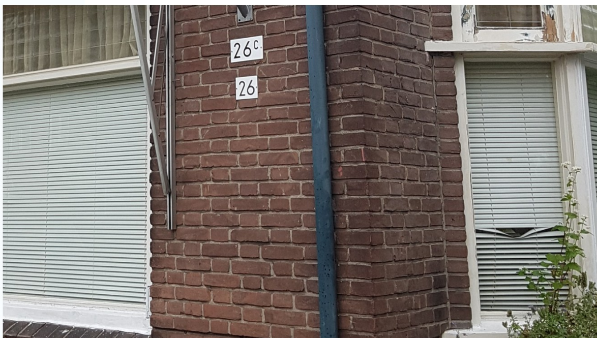
Figuur 9. Gevel van de woning op nr. 26. Deze woning heeft een enkelsteense muur.
