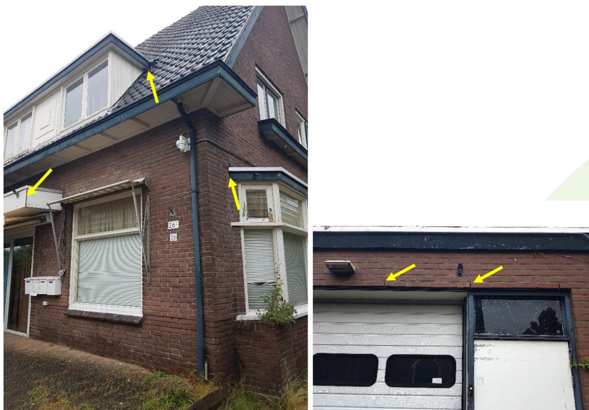
Figuur 5. Enkele locaties waar zich openingen bevinden in het woonhuis van nr. 26 - 26c (links, gele pijlen) en enkele van de open stootvoegen boven de garagedeur van het installatiebedrijf (rechts, gele pijlen).
