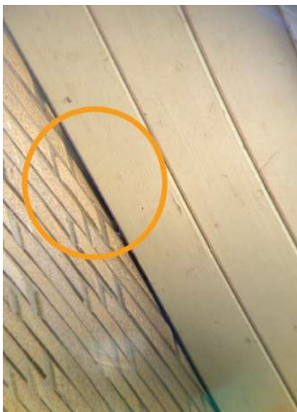
Afbeelding 13. Opening tussen boeidelen en de muur
