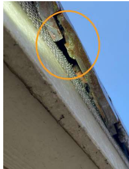
Afbeelding 12. Opening onder kantpan
