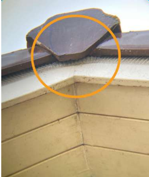
Afbeelding 17. Vrije nokpan, boeideel bekleed met gaas.
