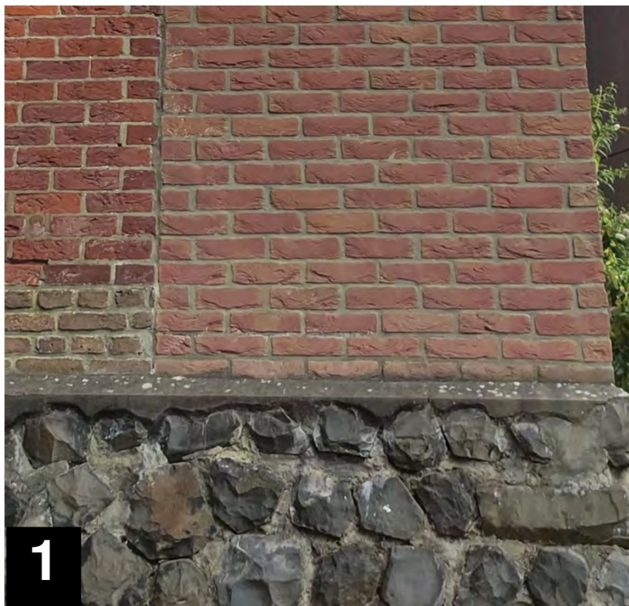
bestaande muur aan de zuidkant
