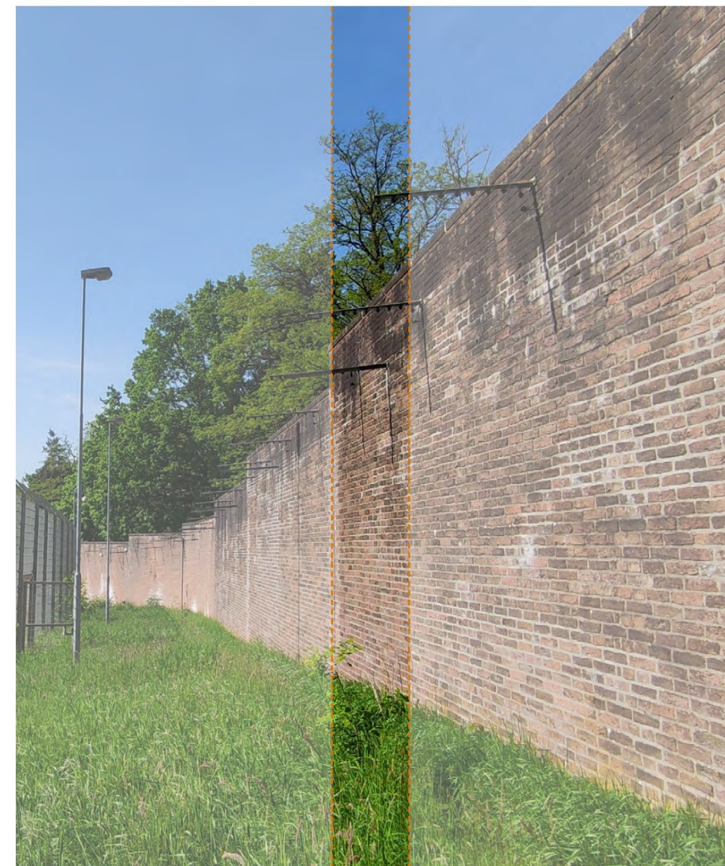
foto van de binnenkant
