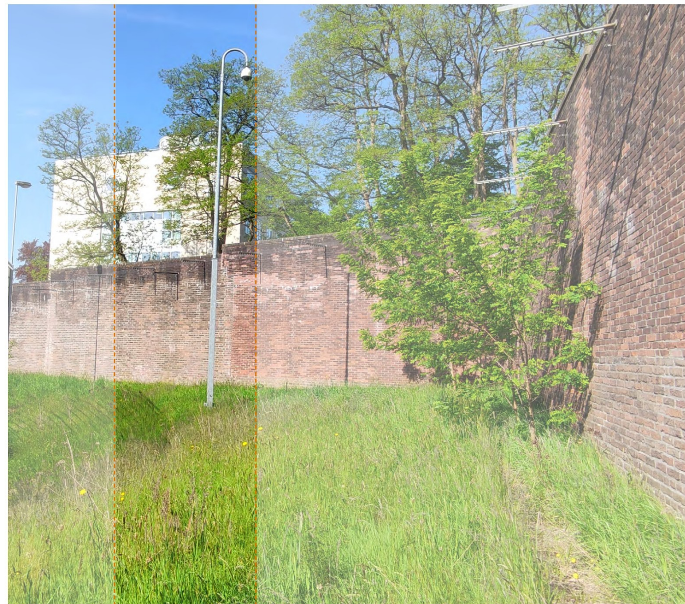
foto van de binnenkant
