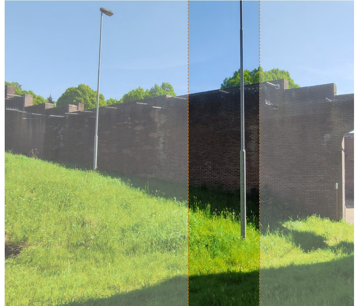
foto van de binnenkant
