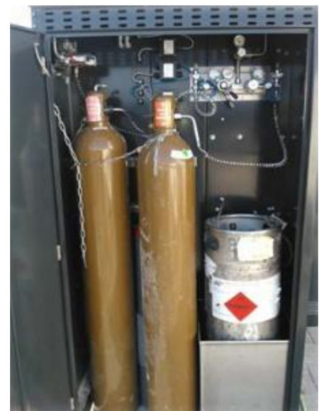
Figuur 3 Calibratiegassen met THT-opslag, in lekbak
