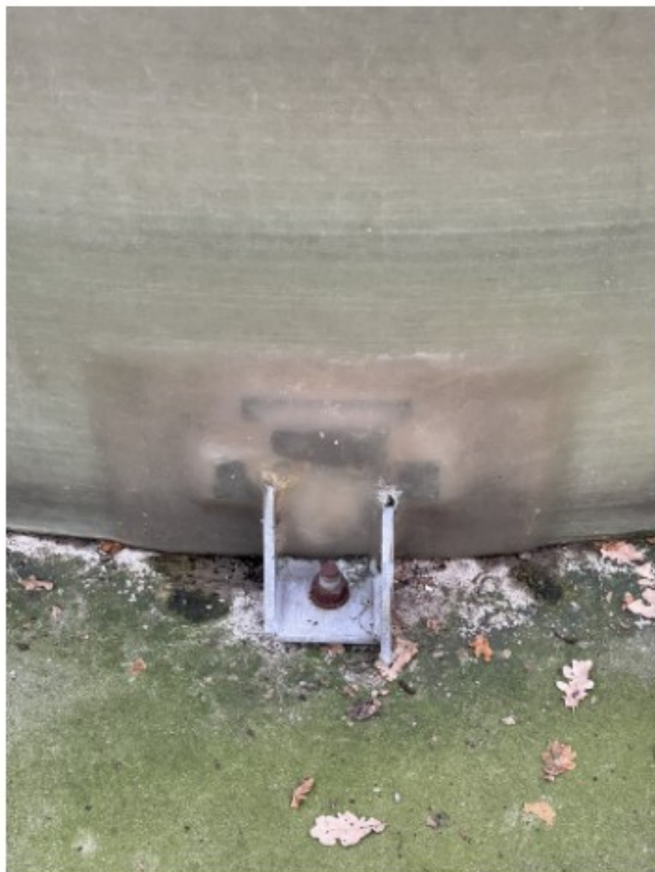
Afbeelding bevestiging hygiënisatiesilo op betonvloer
