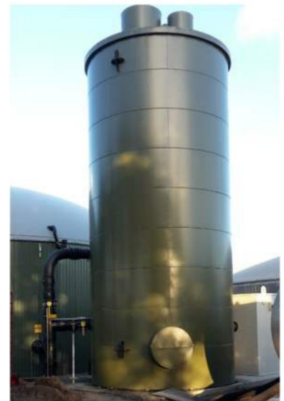
FIGUUR 3 BESTAANDE S&H SILO
