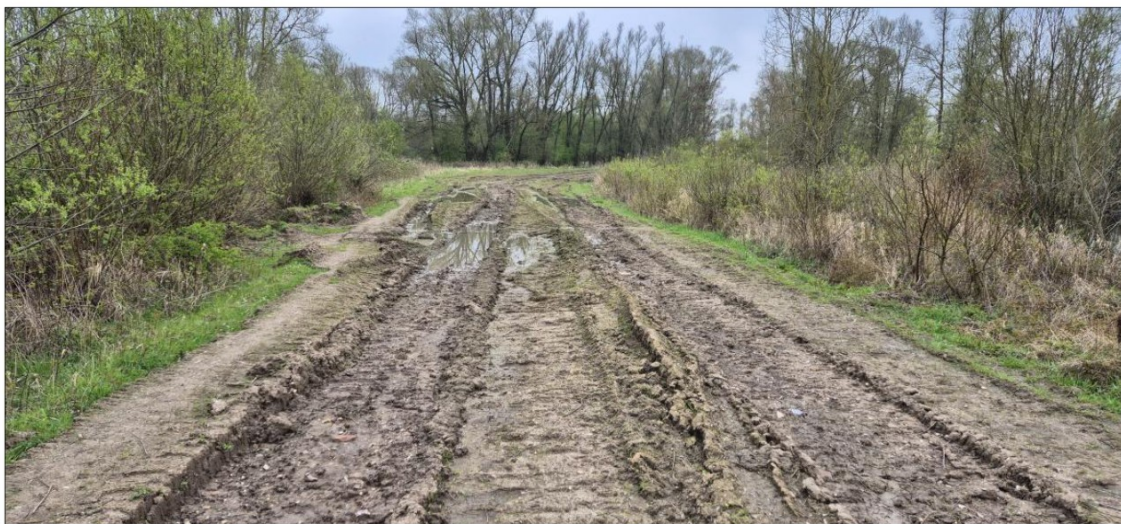
Figuur 4. De beoogde rijroute moet worden vlak gemaakt alvorens rijplaten kunnen worden gelegd.
