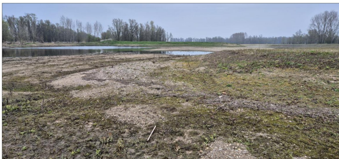
Figuur 2. De vegetatie is recent voorafgaand aan de graafwerkzaamheden gemaaid/geklepeld.
