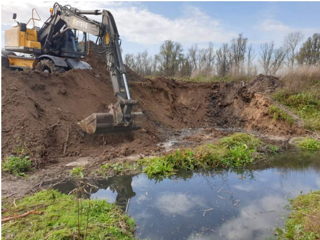
Figuur 4 Machinaal afgraven van de burchtlocatie.
