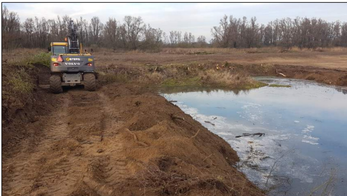
Figuur 5 Verwijderen van vegetatie en egaliseren van oever.
